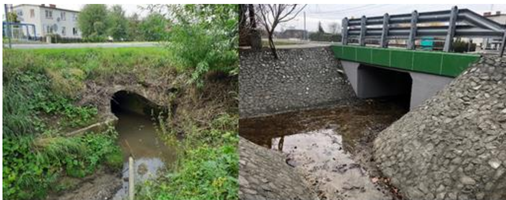
Rysunek 55 - zdjęcia przepustu w ciągu drogi powiatowej 2633S w Jasienicy przed inwestycją (po lewej) i po inwestycji (po prawej)
