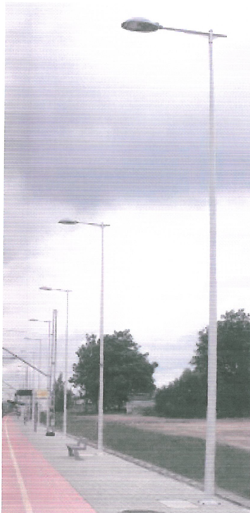
Słup oświetleniowy aluminiowy SAL-80M z wysięgnikiem WR-15/1 Prod. ROSA Oprawa LED BGP 203 Philips
