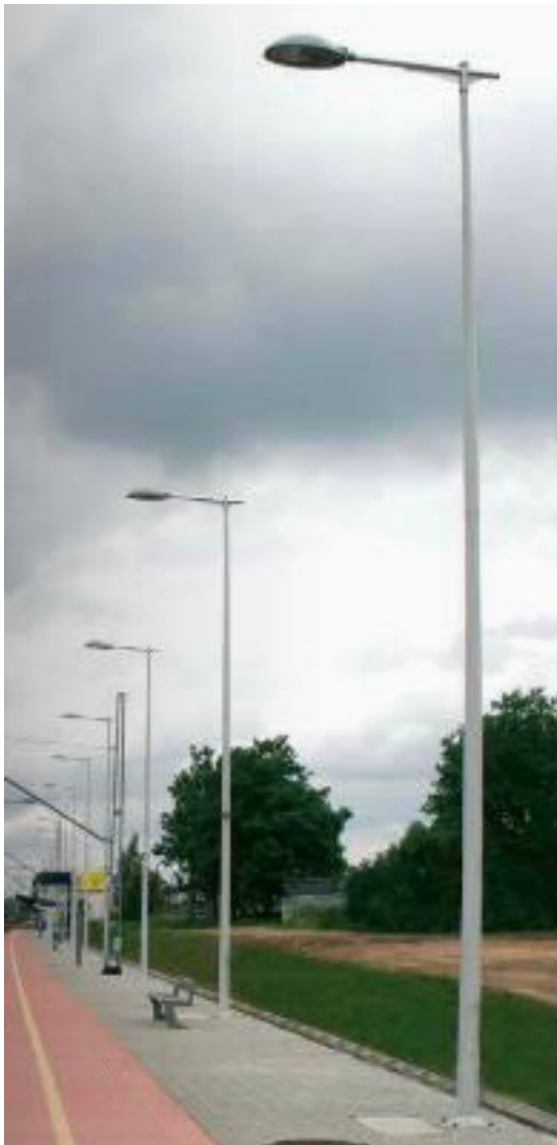
Słup oświetleniowy aluminiowy – 8,0 m z wysięgnikiem WR-15/1 Oprawa LED, 55 W
