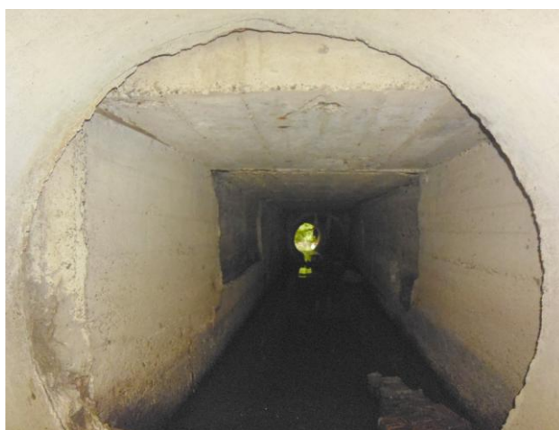
Zdj. 2. Zmiana przekroju przepustu z rurowego na prostokątny w części środkowej. W oddali widoczny wlot do drugiego odcinka rurowego.
