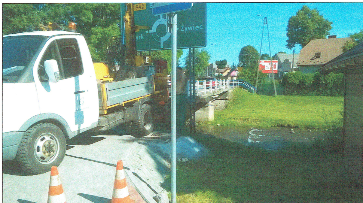
Fot. 2. Widok istniejącego obiektu mostowego od strony południowo-wschodniej. Wiertnica w trakcie wiercenia otworu nr 1.
