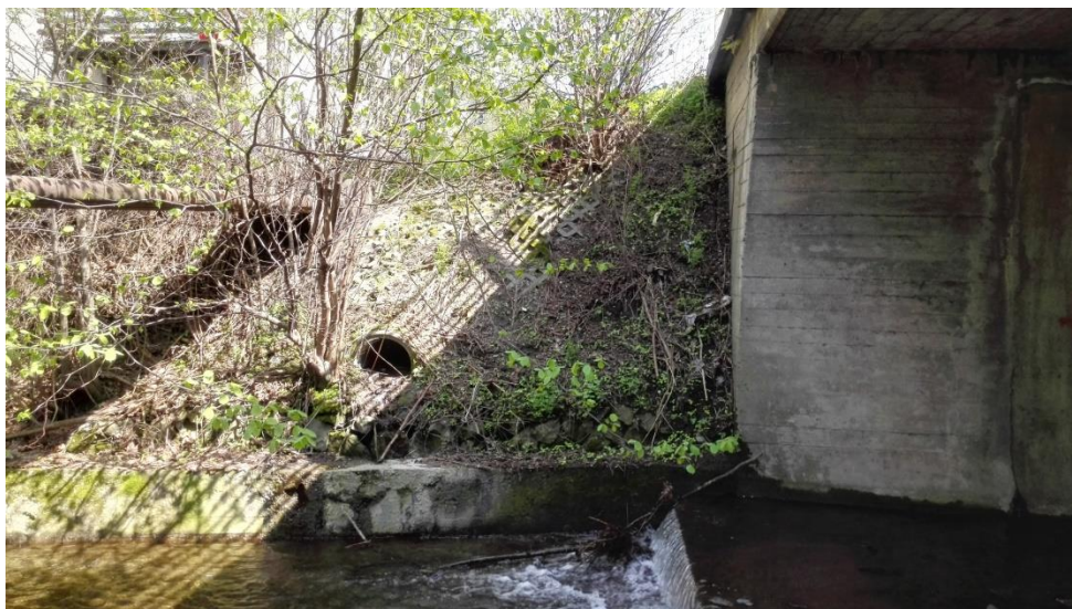
Widok na wylot istniejącego przepustu betonowego fi 500 w rejonie obiektu K-3 do potoku „Szeroki Potok” - do oczyszczenia
