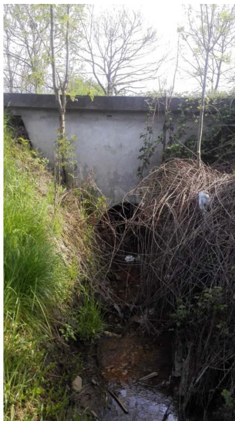
Istniejący przepust żelbetowy o średnicy \phi 1200 mm
