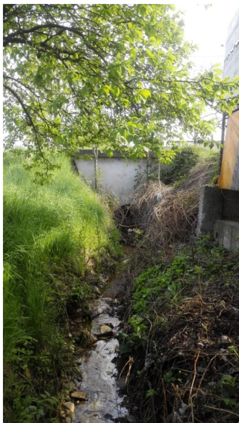
Istniejący rów melioracyjny przejmujący wody z przepustu Nr 1 ( szerokość dna 1,0 m, wysokość linii brzegowej 0,5 m, pochylenia skarp 1:1,5)
