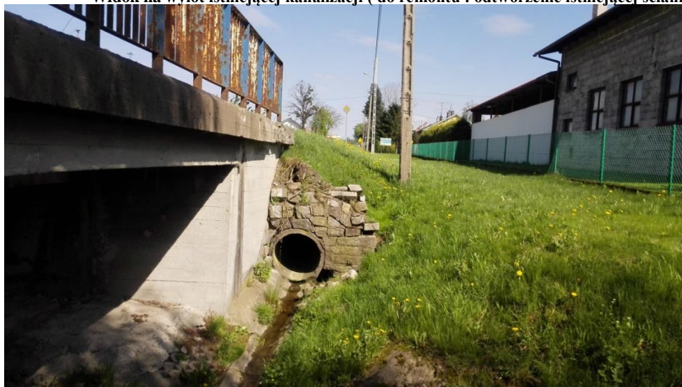
Widok na wylot istniejącej kanalizacji ( do remontu : odtworzenie istniejącej ścianki czołowej )
