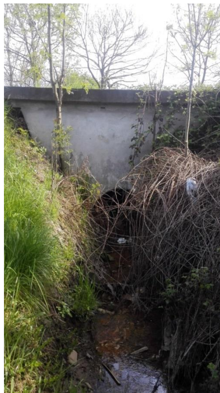
Istniejący przepust żelbetowy o średnicy fi 1200 mm
