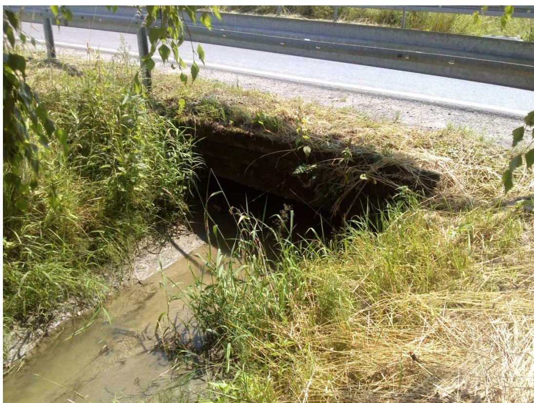
Fot. 4 Widok przepustu od strony wylotu
