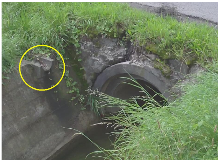
Rys. 1. Włot remontowanego przepustu. W żółtym okręgu pokazano korytko ściekowe odwod. drogi..
