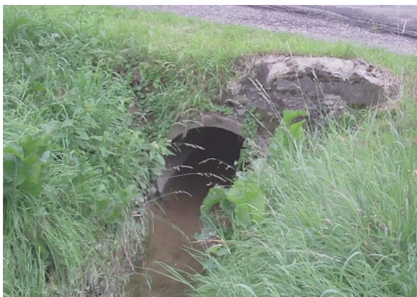
Rys. 2. Wylot remontowanego przepustu.
