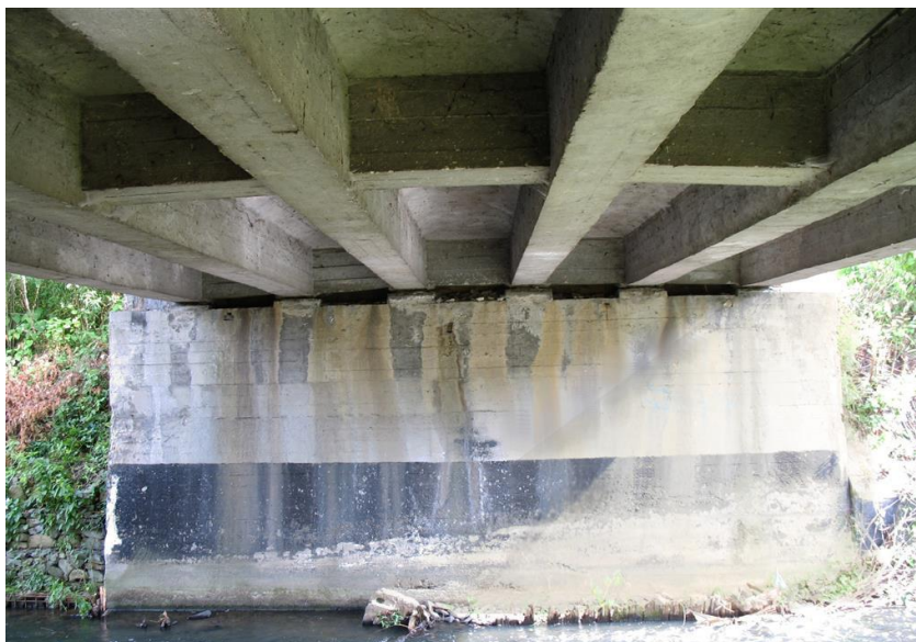
Widok na przyczółek południowy-wschodni i poprzecznice w środku rozpiętości
