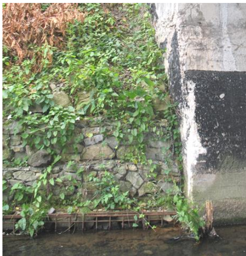
◀ Umocnienie brzegów koszami kamiennymi: na dnie kosze ze sztywnych prętów, na nich 2 rzędy koszy w siatkach stalowych.
