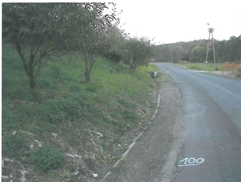
Fot.5. Efekt tymczasowych napraw. Zabezpieczenie skarpy poniżej posesji nr 29 ażurowymi elementami betonowymi. Rów przydrożny umocniono, poszerzono i nadsypano pobocze oraz naprawiono nawierzchnię w miejscu jej wcześniejszego obniżenia.
