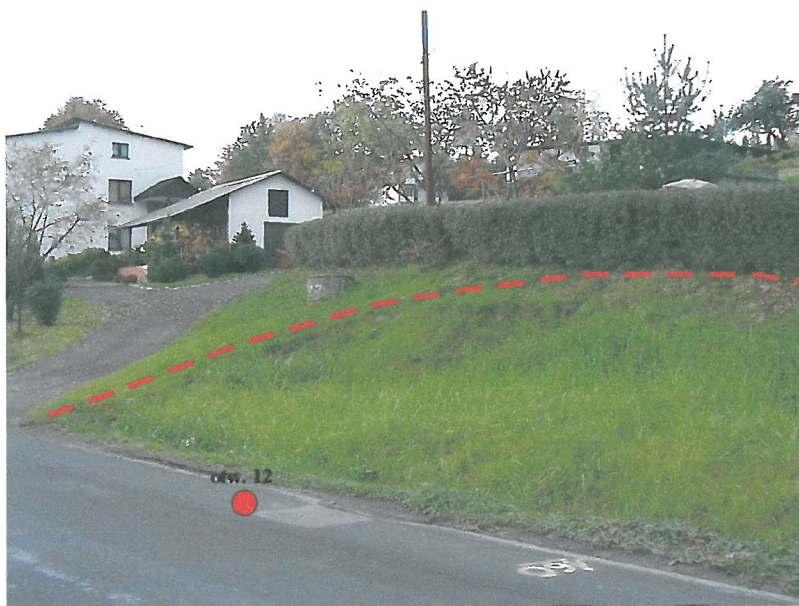
Fot. 7. Małe osuwisko w obrębie krawędzi dolnej półki terasowej, poniżej posesji nr 33. Na zdjęciu widoczna jest studnia powyżej osuwiska, cały czas eksploatowana oraz dojazd do posesji nr 29 poprowadzony nasypem żużlowym (kolorem czerwonym podkreślono linię krawędziową osuwiska)
