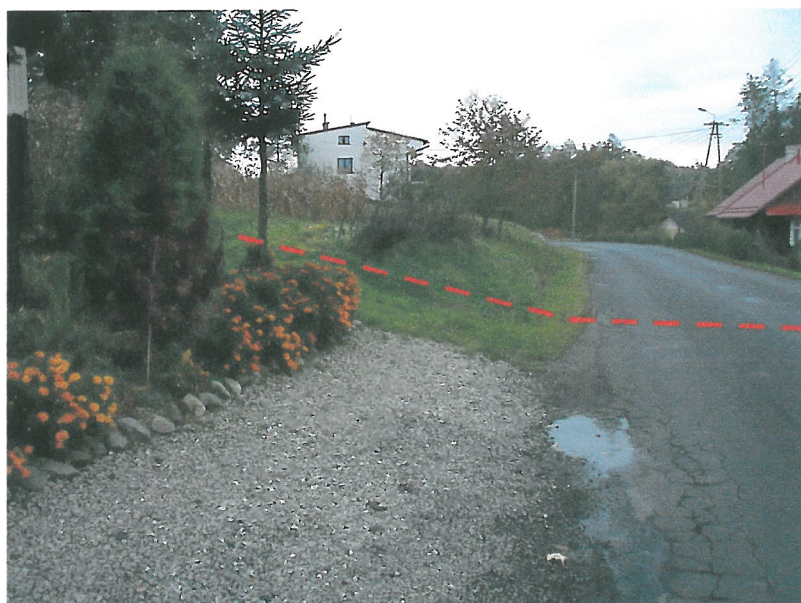
Fot.1. Początek odcinka na wysokości posesji nr 27. Widoczne spękania nawierzchni od strony przystokowej (linią przerywaną wskazano przebieg przekroju geol.-inż. nr V-V')
