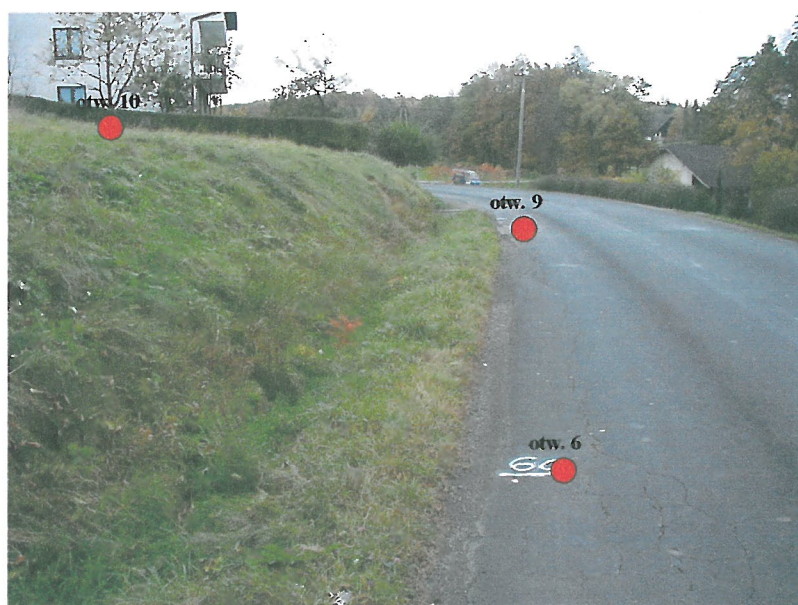
Fot.2. Odcinek drogi i skarpy niższej terasy osuwiskowej pomiędzy posesjami nr 27 i 29. Widoczne duże nachylenie krawędzi skarpy utworzone w wyniku podcięcia rowem odwadniającym oraz spękania i obniżenie nawierzchni od strony przystokowej (na zdjęciu naniesiono miejsca lokalizacji niektórych wyrobisk).
