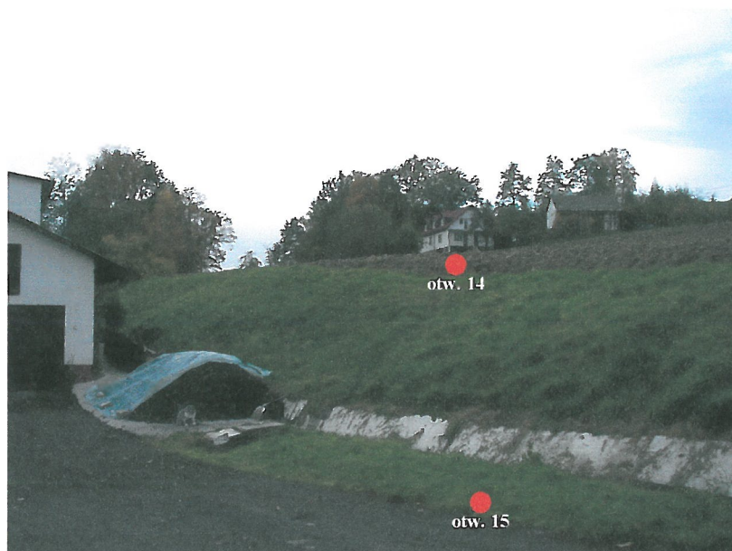
Fot.6. Zdeformowana i napierająca na budynek mieszkalny i garaż posesji nr 29 skarpa górnej półki terasowej. Deformacja jest wynikiem obsunięcia gruntu po wykonaniu linii uzbrojenia podziemnego wzdłuż górnej krawędzi skarpy. Za pryzmą węgla widoczny niski mur oporowy wykonany przez właściciela obiektu.
