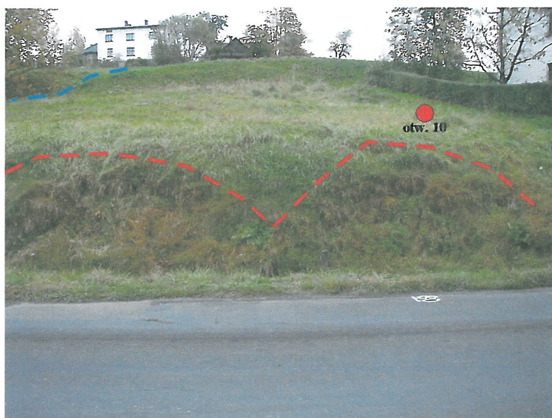
Fot.4. Dwa małe osunięcia w obrębie krawędzi dolnej części niższej terasy ( granice podkreślono linią czerwoną). na działce obok posesji nr 29. W tle krawędź terasy wyższej oraz posesja przy ul. Akacjowej 13, od której biegnie rów melioracyjny z fot. nr 3. Widoczne również obniżenie nawierzchni od strony przystokowej, wzdłuż nieszczelnego rowu przydrożnego.
