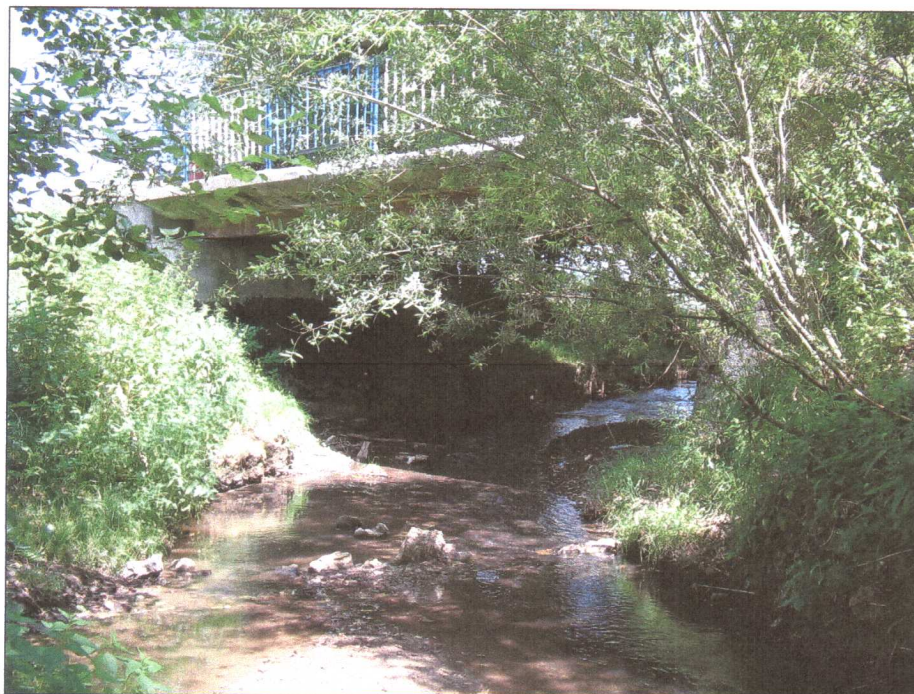
Fot. nr 3. Zdjęcie koryta Łozińskiego Potoku od strony południowej mostu, ukazujące głębokość wcięcia erozyjnego i wysokość mostu.
