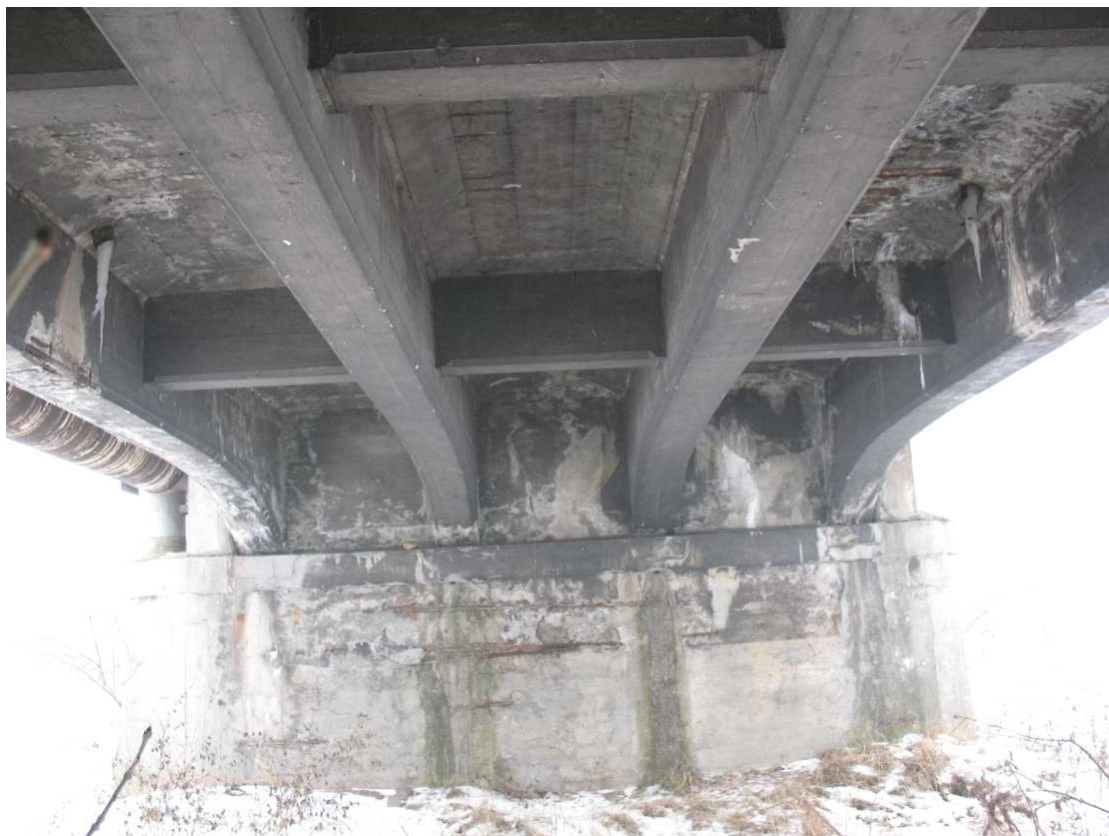
Fot. 35 Wyloty wpus tów mostowych, zacieki na konstrukcję nośną obiektu
