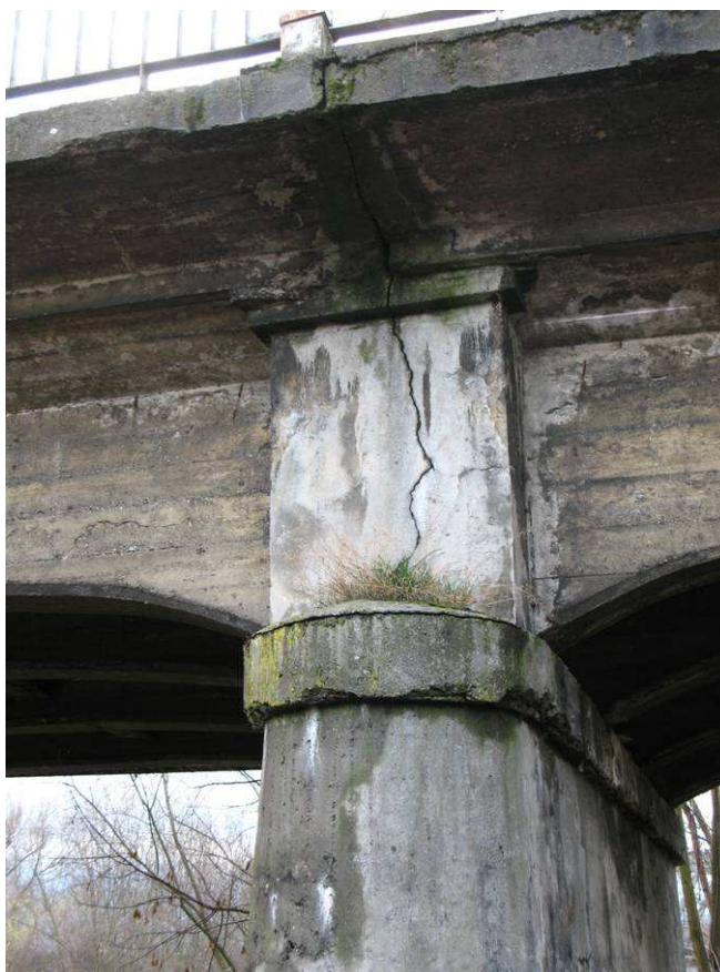
Fot. 37 Widok na dylatację mostu na filarze, pęknięta ścianka maskująca przerwę dylatacyjną.
