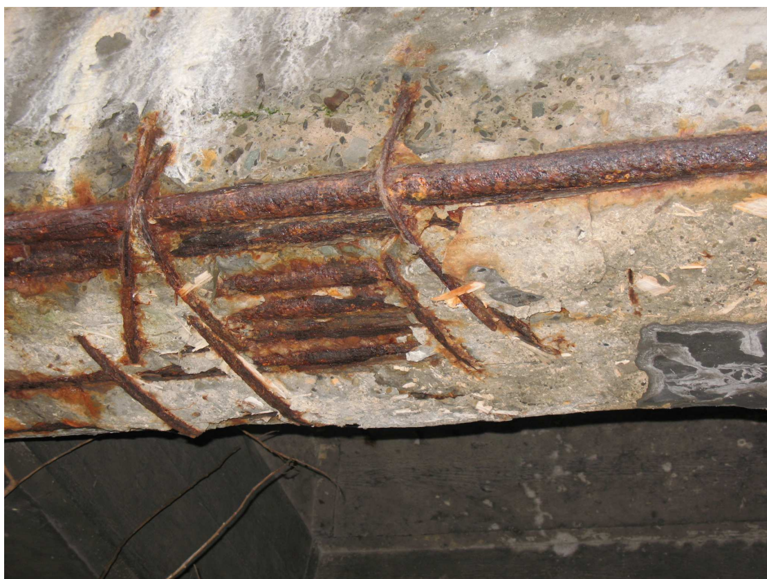
Fot. 16 Układ zbrojenia w dźwigarze, widoczne złamanie zasad rozmieszczania zbrojenia podłużnego i poprzecznego, brak zachowania wymaganej otuliny prętów.
