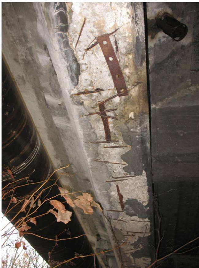
Fot. 17 Rozmieszczenie strzemion w dźwigarze, brak wymaganych otulin prętów.
