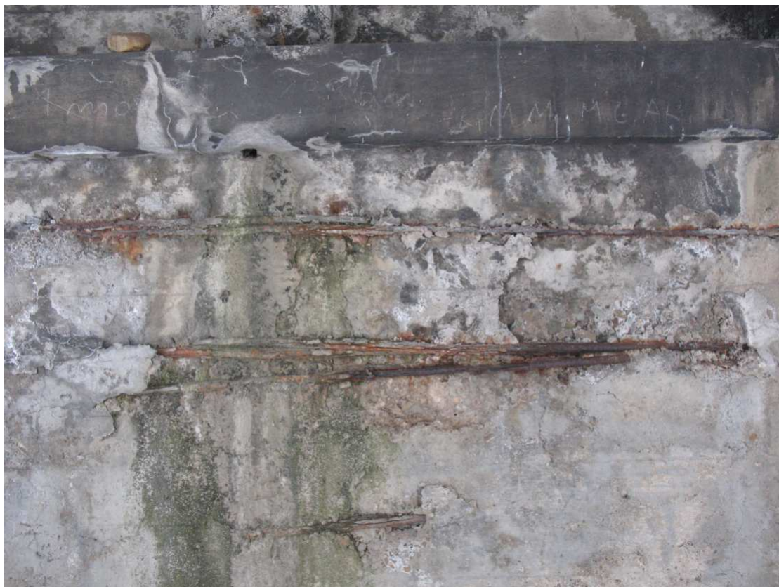
Fot. 29 Odsłonięte zbrojenie filara, brak zbrojenia poprzecznego, zacieki z otworu z wnęki podłożyskowej.
