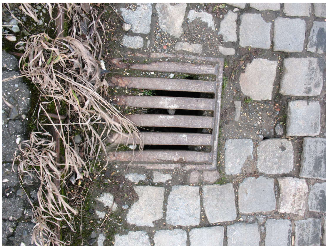
Fot. 34 Widok na nieodróżny wpust mostowy na obiekcie.
