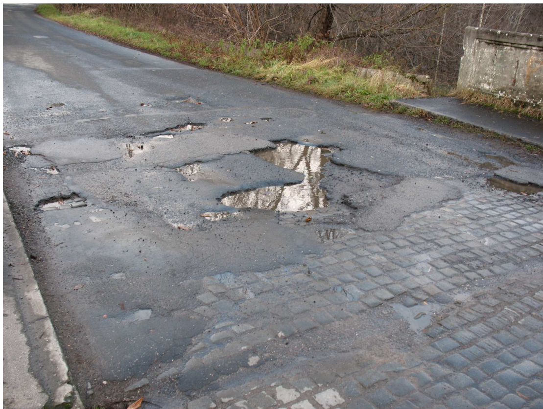
Fot. 50 Dojazd do mostu od strony Goczałkowic, prawdopodobny brak płyt przejściowych.
