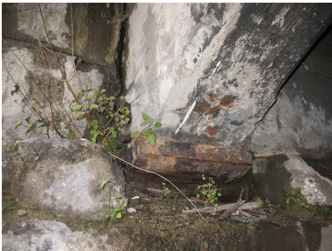
Fot. 22 Stan techniczny łóżysk na przyczółku od strony Goczałkowic, całkowita destrukcja wałka łożyska.
