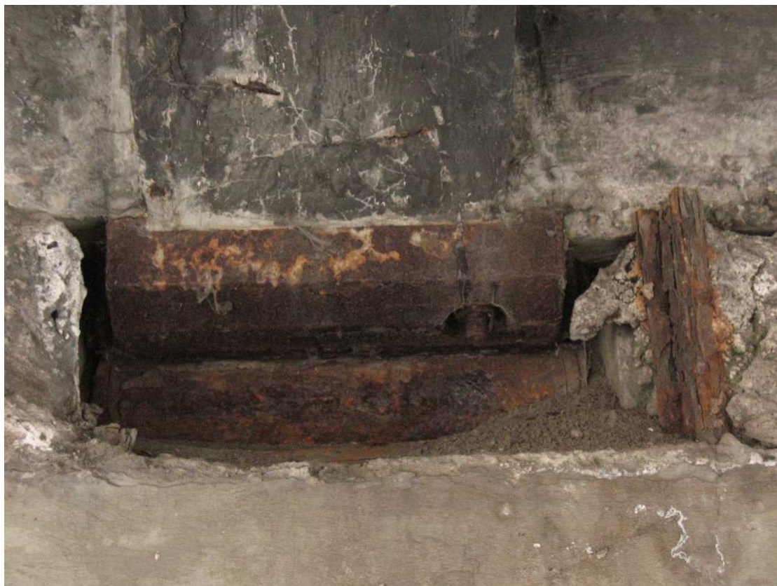
Fot. 42 Zamocowanie łożyska w dźwigarze i podporze. Odsłonięta wnęka podłożyskowa.
