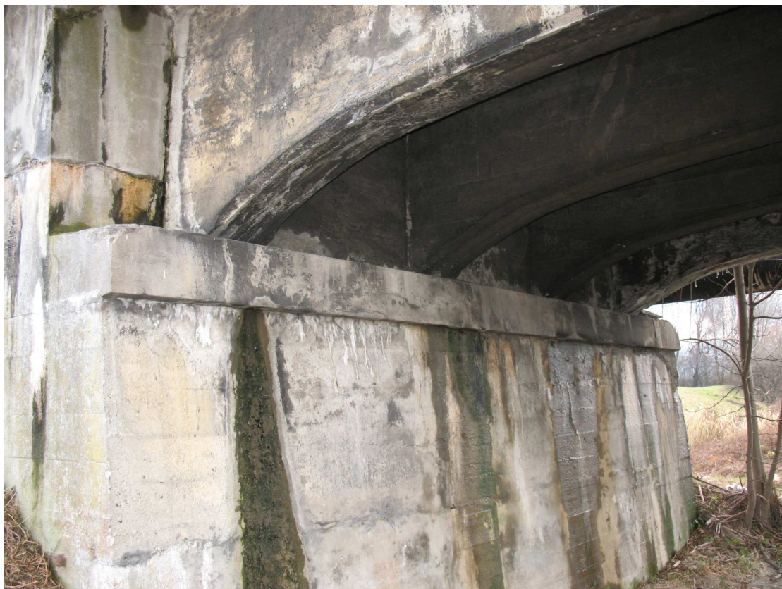
Fot. 24 Widok na przyczółek od strony centrum, liczne zacieki i wykwity, korozja biologiczna.
