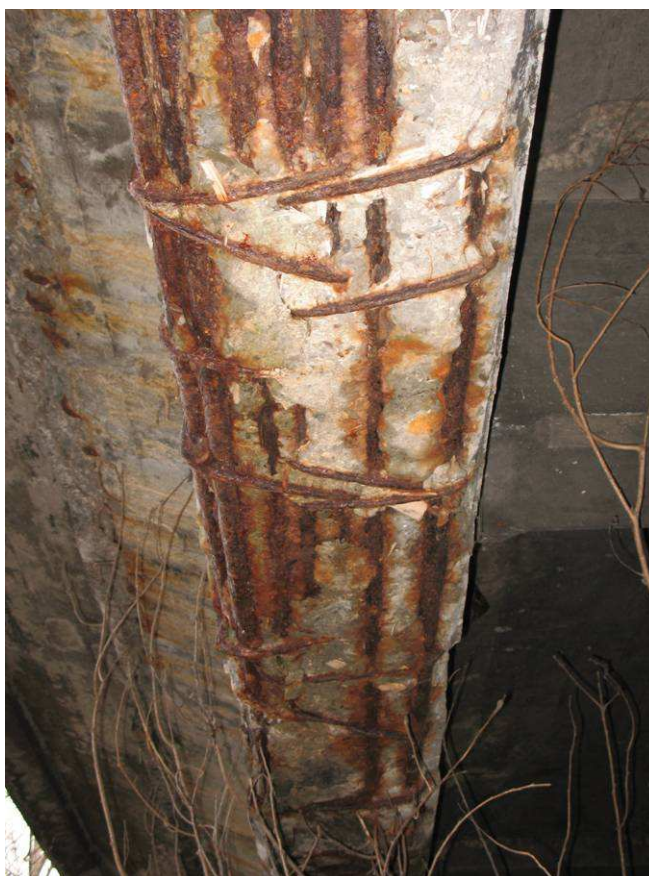
Fot. 14 Stan techniczny dźwigarów skrajnych w przęśle nr 6, niedbalstwo wykonawcze zbrojenia.
