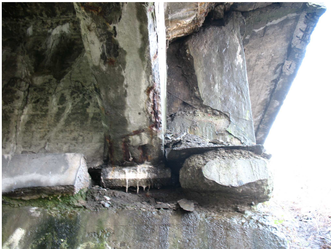
Fot. 23 Oparcie dźwigara na przyczółku, całkowita destrukcja ławy podłożyskowej, ścięcie naroża przyczółka, zarysowanie poprzecznicy podporowej.
