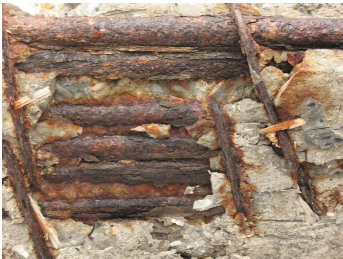
Fot. 18 Stopień zaawansowania korozji zbrojenia w dźwigarze skrajnym obiektu.
