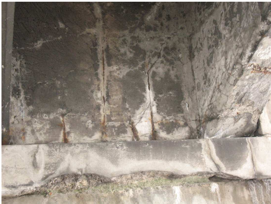
Fot. 20 Zarysowanie, pęknięcie poprzecznic podporowej obiektu.
