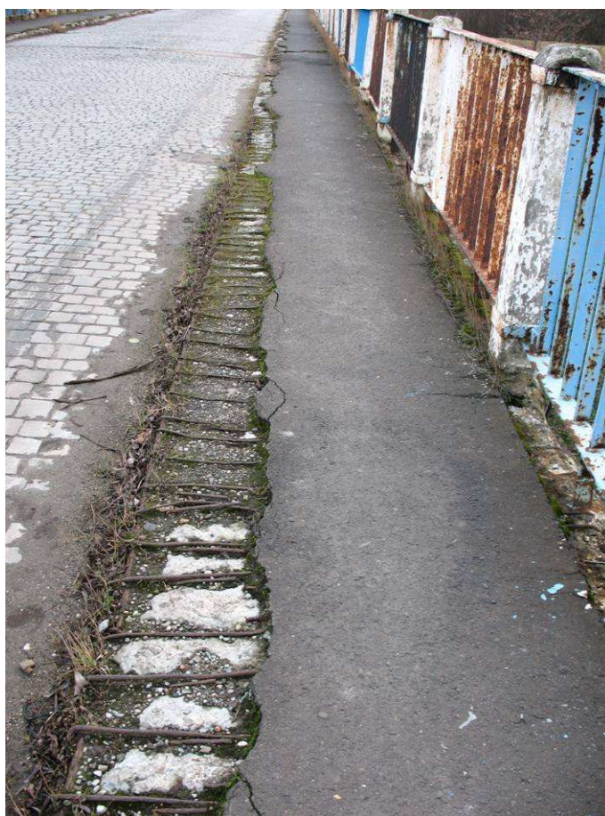
Fot. 8 Widok na kapę chodnikową, nawierzchnia kapy, stan techniczny kapy i krawężnika.
