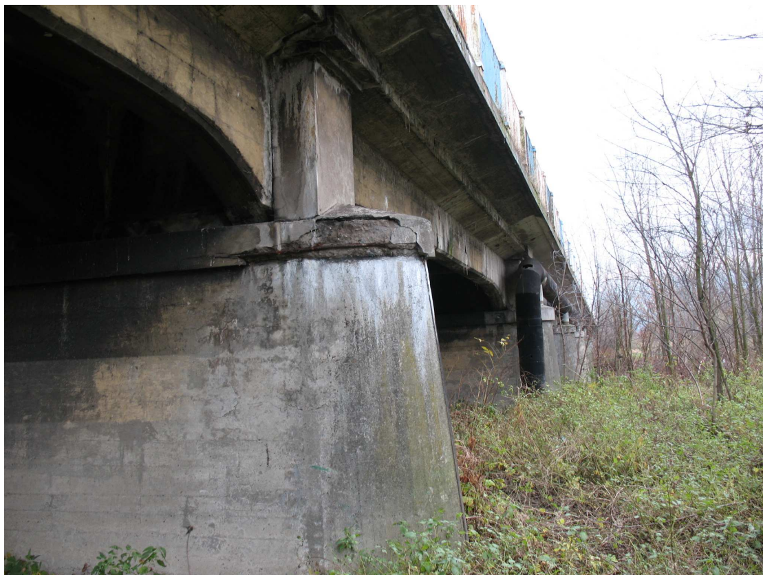
Fot. 49 Przejście ciepłociągu/kanalizacji tłoczzonej z obiektu do gruntu (przęsło nr 2, od strony Goczałkowic).
