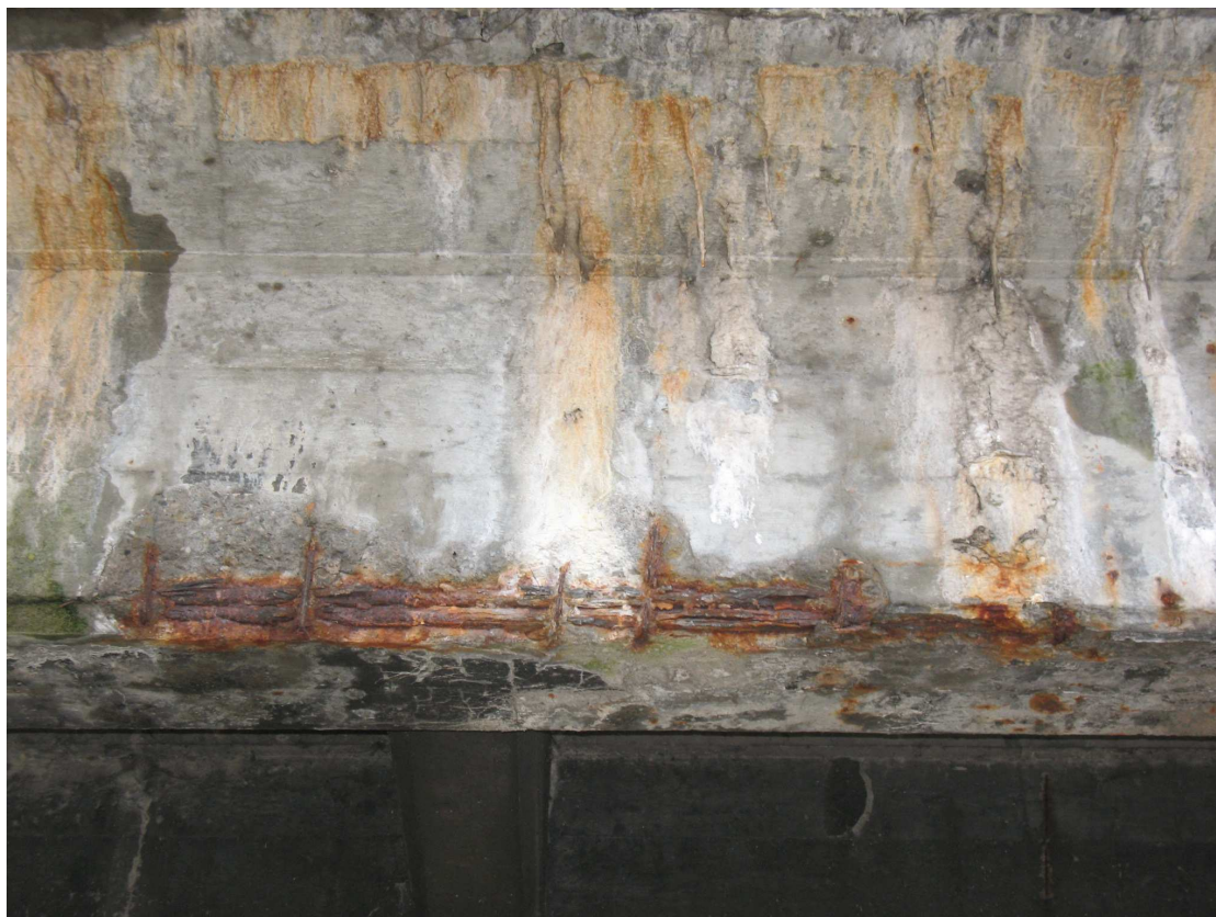
Fot. 15 Widok z boku dźwigara skrajnego obiektu, widoczne zacieki, zarysowania i wykwyty.
