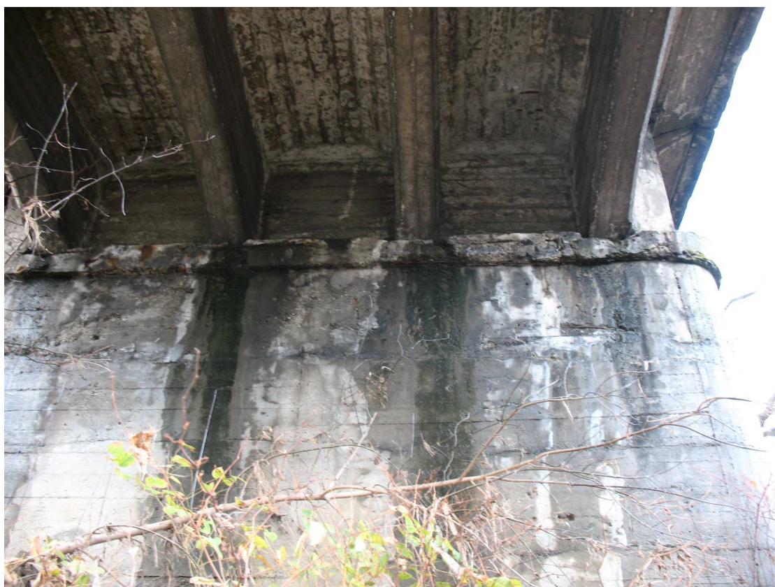
Fot. 12 Płyta pomostowa z filarem, korozja biologiczna i chemiczna pomostu i podpory.
