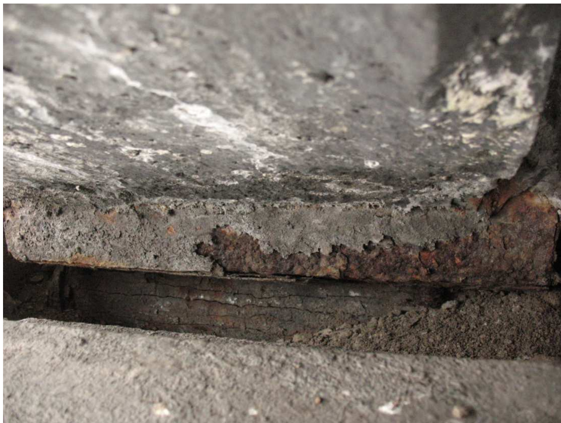
Fot. 41 Łożysko styczne, stalowe na przyczółku od strony centrum (łożysko znajduje się we wnęce podłożyskowej, niewidocznej z poziomu terenu).
