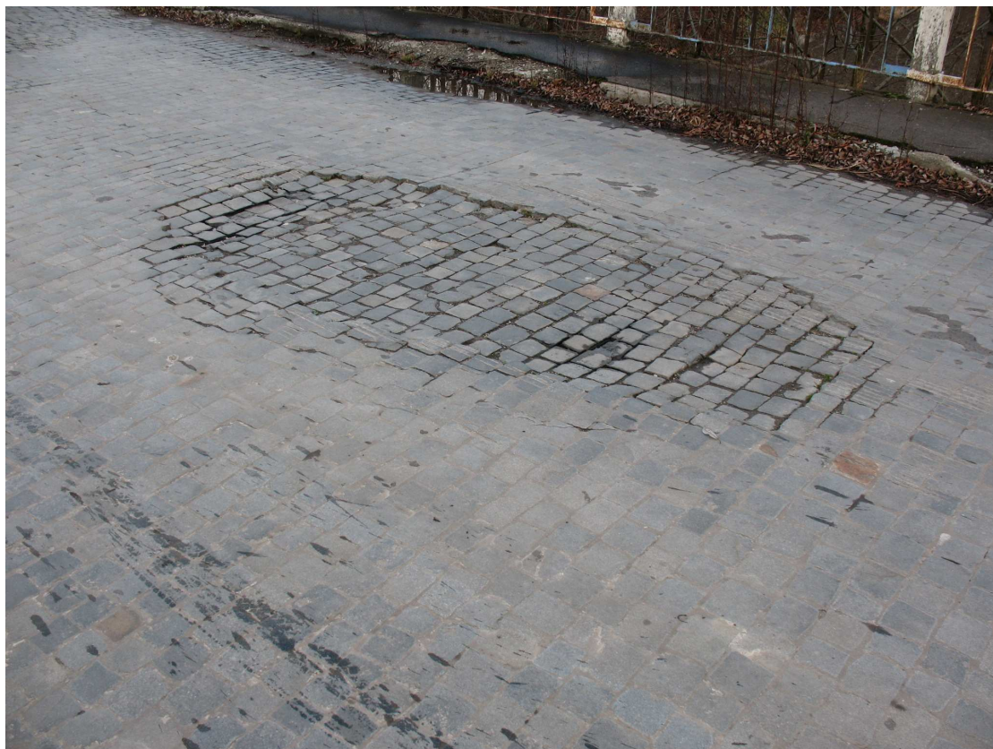
Fot. 7 Przemieszczenie i zapadnięcie się kostki na obiekcie.
