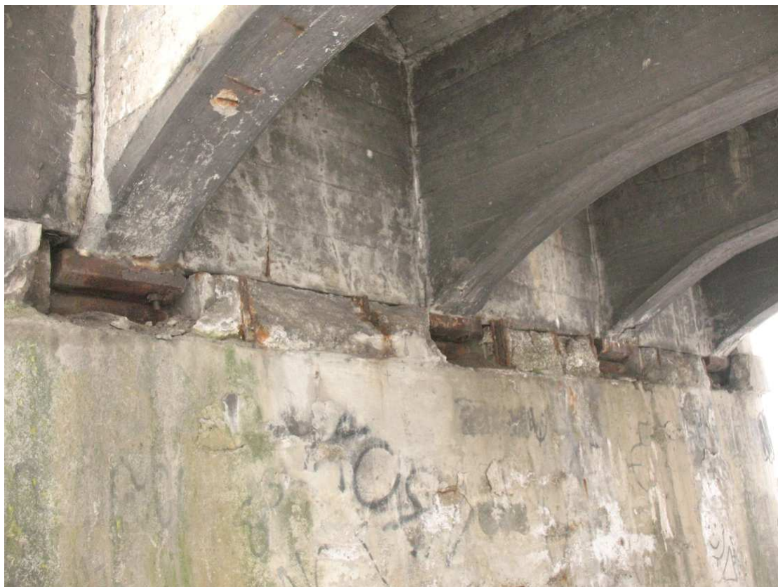
Fot. 31 Widok na filar nr 7, całkowita destrukcja oczepu filara, brak zbrojenia poprzecznego i podłużnego. Widoczna korozja łożysk stalowych, odsłonięta wnęka podłożyskowa.
