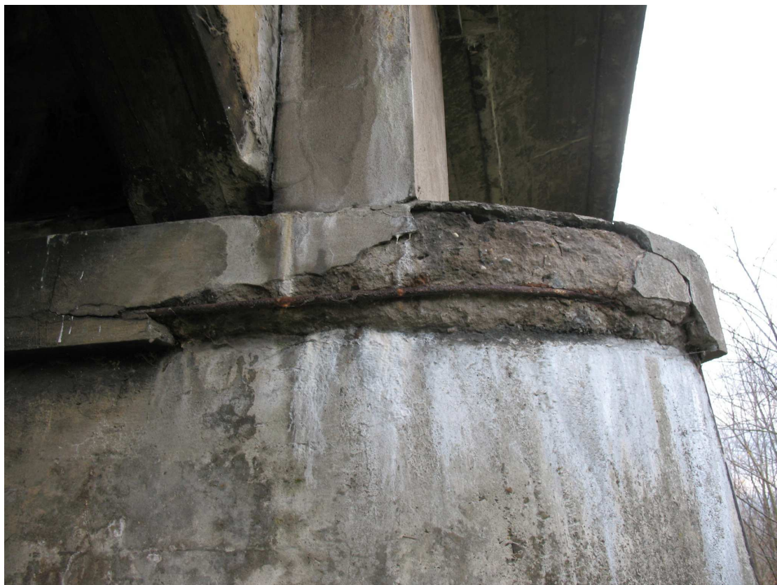
Fot. 27 Widok na oczep filara nr 8, brak wymaganej otuliny, brak zbrojenia poprzecznego, nie zachowano zasadniczych zasad rozmieszczania zbrojenia konstrukcyjnego i nośnego.
