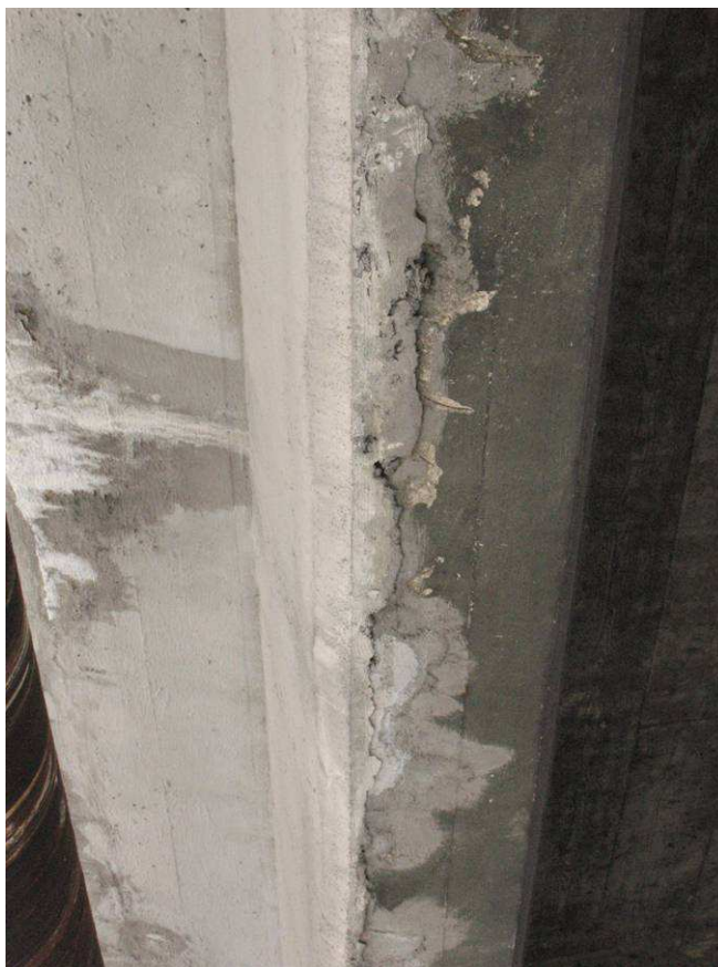
Fot. 19 Widoczne poszerzenie dźwigarów skrajnych od strony górnej wody w wyniku późniejszego remontu, dostosowania szerokości dźwigara do wymaganej szerokości.
