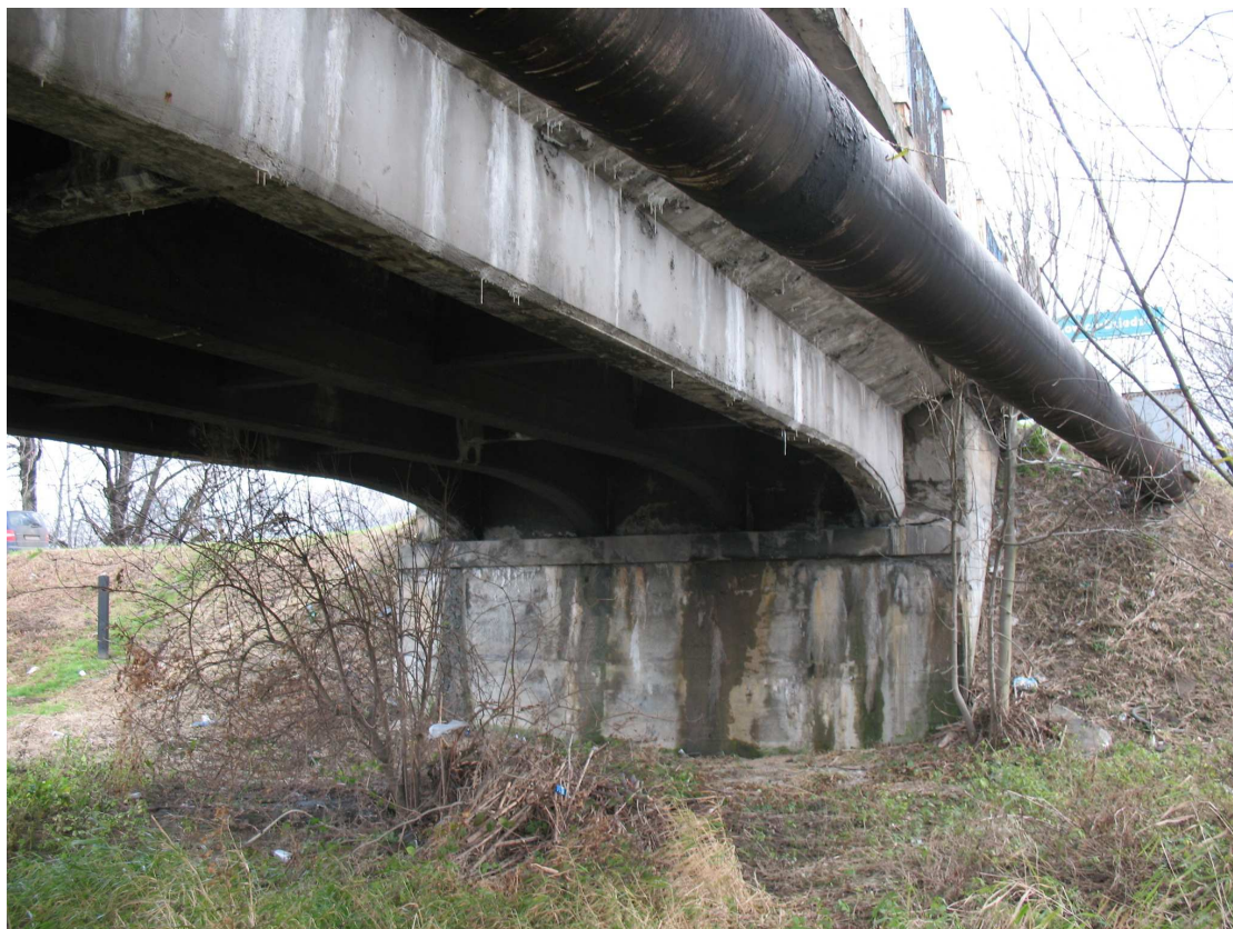
Fot. 47 Podwieszenie urządzenia obcego do obiektu, od strony centrum. Widok na skarpy przyczółka.
