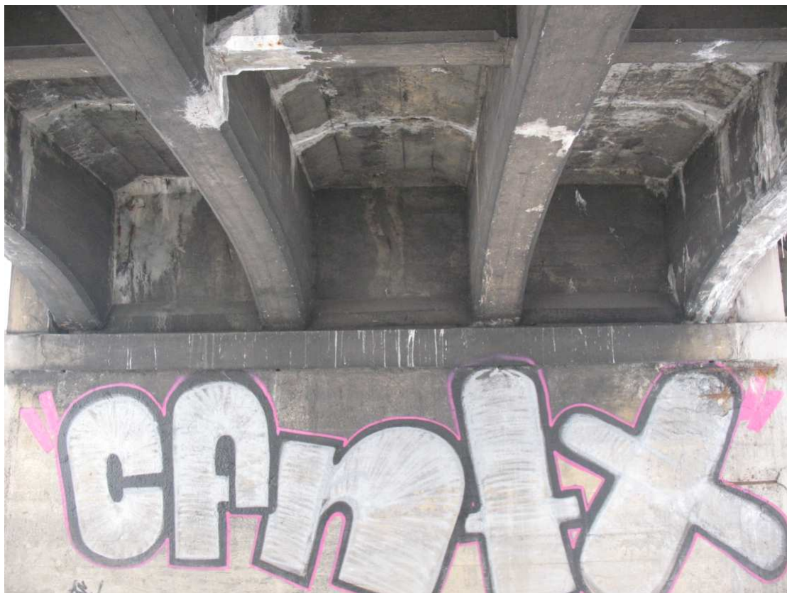
Fot. 33 Białe wykwyś świadczące o nieszczelnej izolacji pomostu
