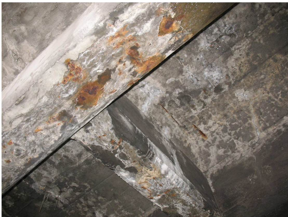
Fot. 32 Uszkodzona izolacja obiektu, liczne zacieki, wykłwity, korozja chemiczna betonu i stali.
