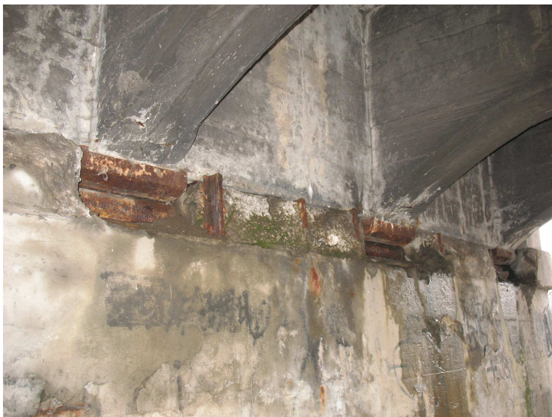
Fot. 40 Widok na łożyska wałkowe (stalowe) na podporze nr 10.
