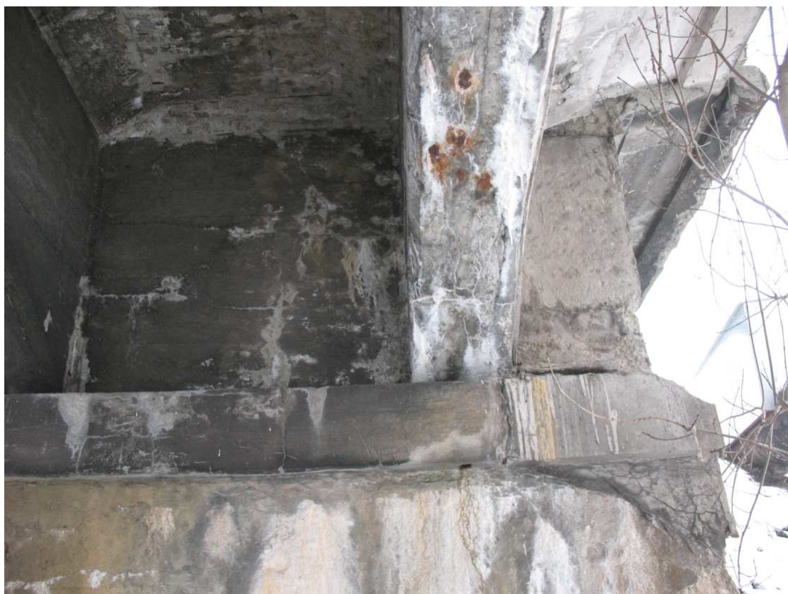
Fot. 28 Oparcie dźwigara na filarze, ścięcie naroża podpory, prawdopodobny brak (lub znikome) zbrojenie górnej części podpory.
