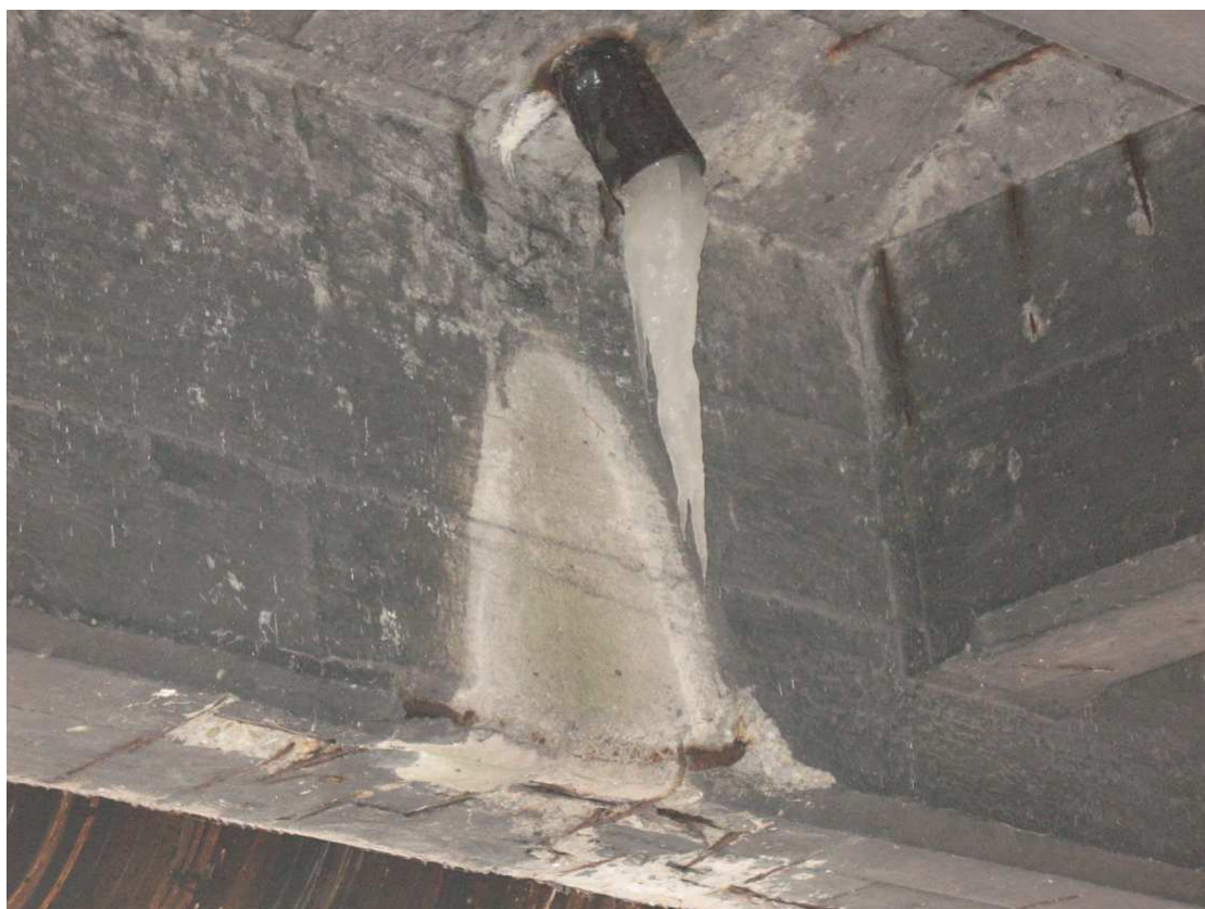
Fot. 36 Wylot z wpustu, zacieki na konstrukcji i co za tym idzie odsłonięte zbrojenie nośne dźwigarów.
