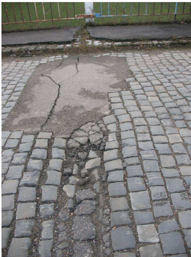
Fot. 39 Dylatacja na jezdni i chodniku, brak wymaganej s wobody przemieszczeń konstrukcji.
