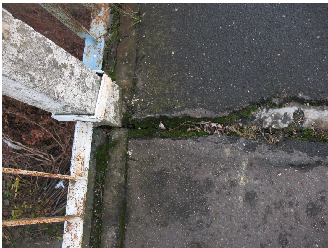
Fot. 38 Dylatacja na chodniku, brak szczelnego wypełnienia przerwy dylatacyjnej.
