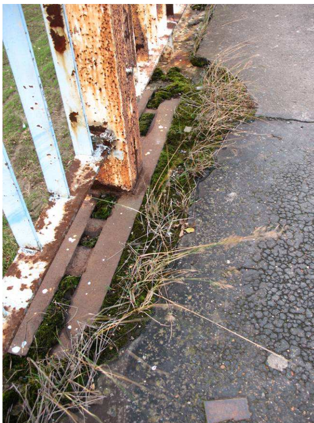
Fot. 44 Zamocowanie stalowego słupka balustrady w konstrukcji chodnika.
