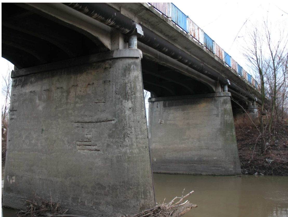
Fot. 48 Oparcie sieci na podporach za pomocą rur stalowych \varnothing 400\text{mm} .
