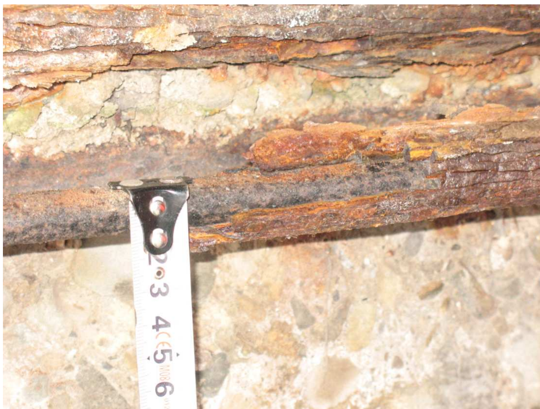
Fot. 30 Stopień zaawansowania korozji prętów, z pręta gładkiego (prawdopodobnie gatunku St3S) \varnothing 20\text{mm} pozostało \varnothing 10\text{mm} (korozja wgłębna).
