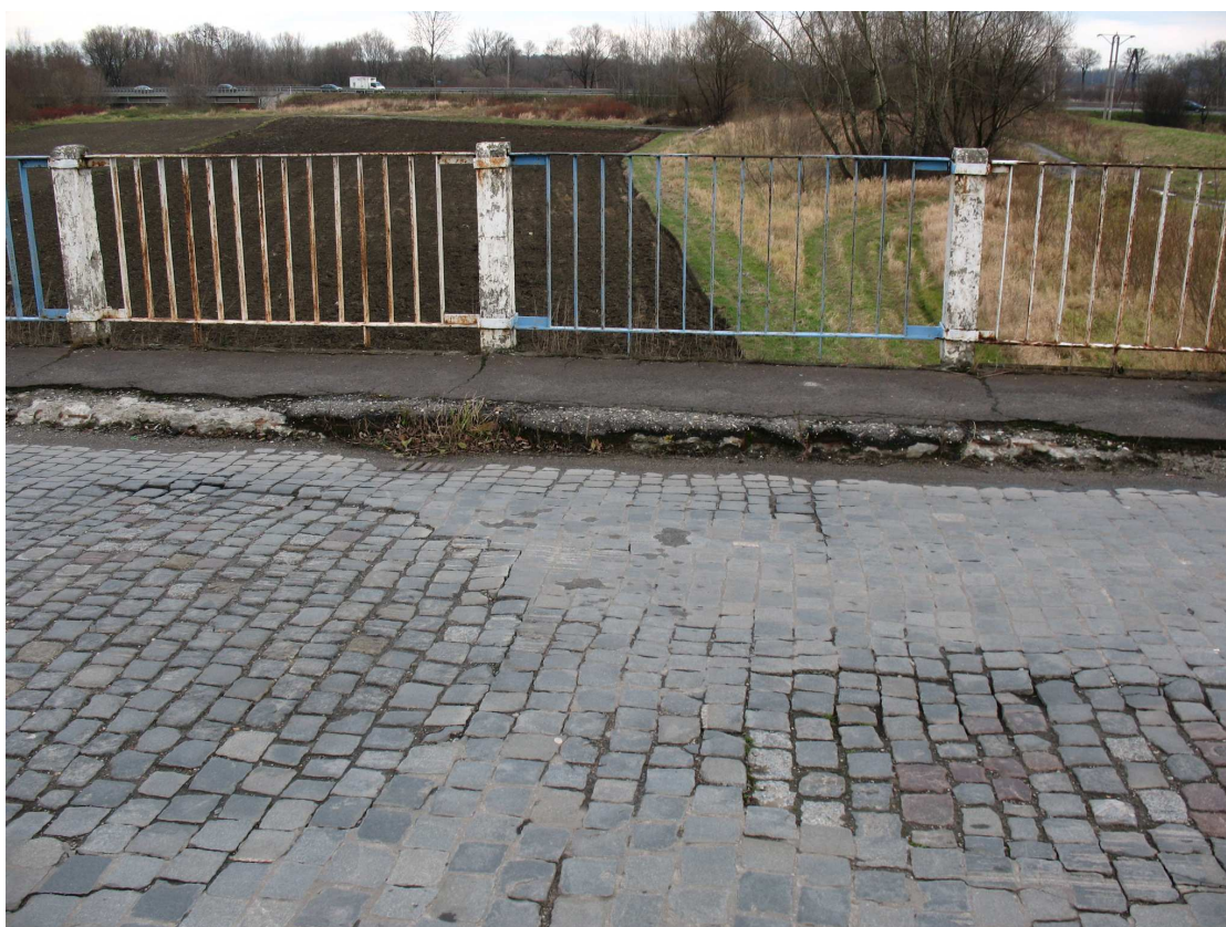
Fot. 6 Deformacje nawierzchni na obiekcie.
