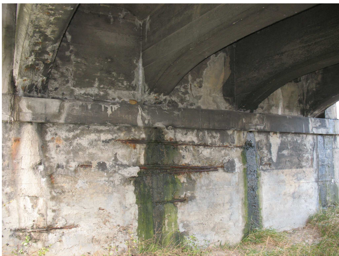
Fot. 26 Widok na filar nr 10, zacieki z wnętrza podłożyskowych, ubytki betonu, korozja biologiczna i chemiczna. Brak wymaganego zbrojenia poprzecznego (strzemion) w filarach, brak zachowania zasad rozmieszczania i otuliny zbrojenia.
