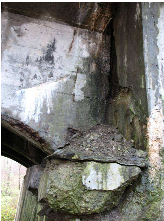
Fot. 21 Oparcie ustroju nośnego na przyczółku od strony Goczałkowic, przedawaryjny stan przyczółka.
