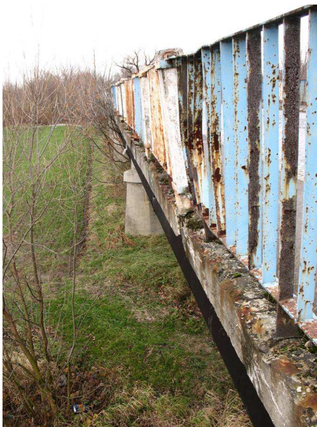
Fot. 43 Balustrada obiektu od strony górnej wody. Widoczne deformacje, ubytki i korozja balustrady i gzymsu.
