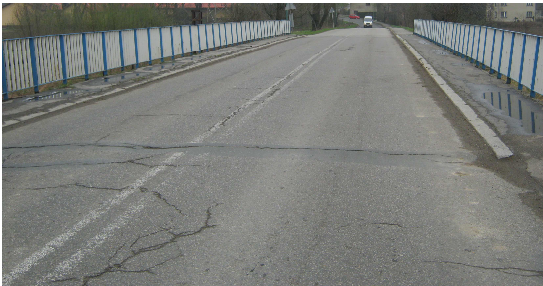
Fot.4. Stan nawierzchni asfaltowej – kierunek Czechowice Dz.
