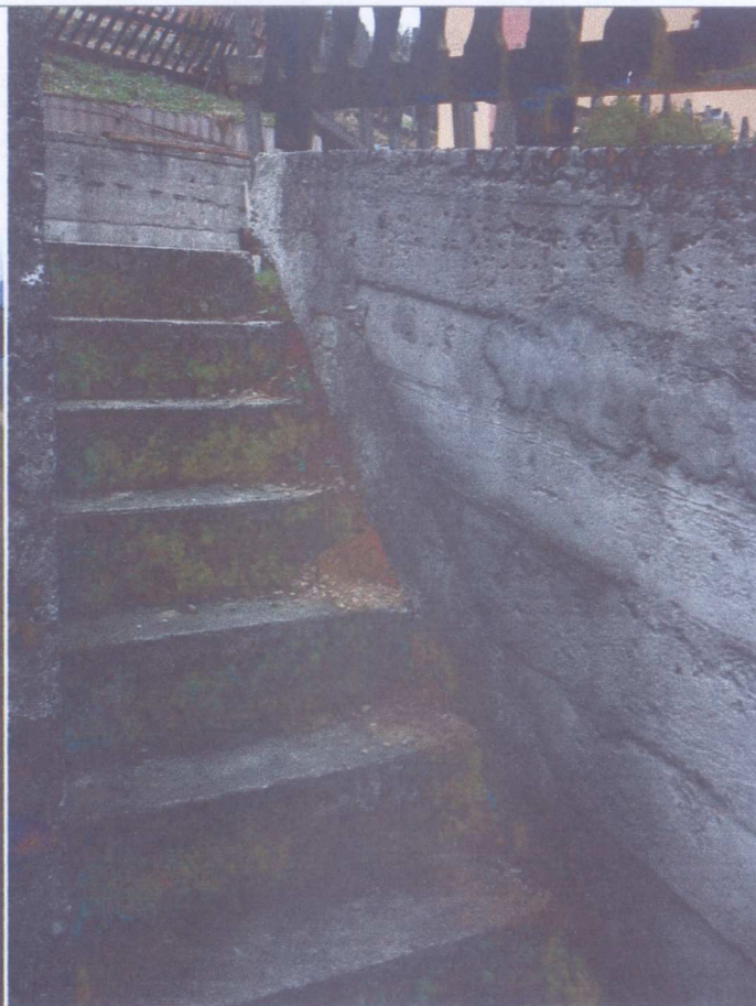
Fot. 7 i 8 Uszkodzony mur oporowy posesji budynku nr 6
