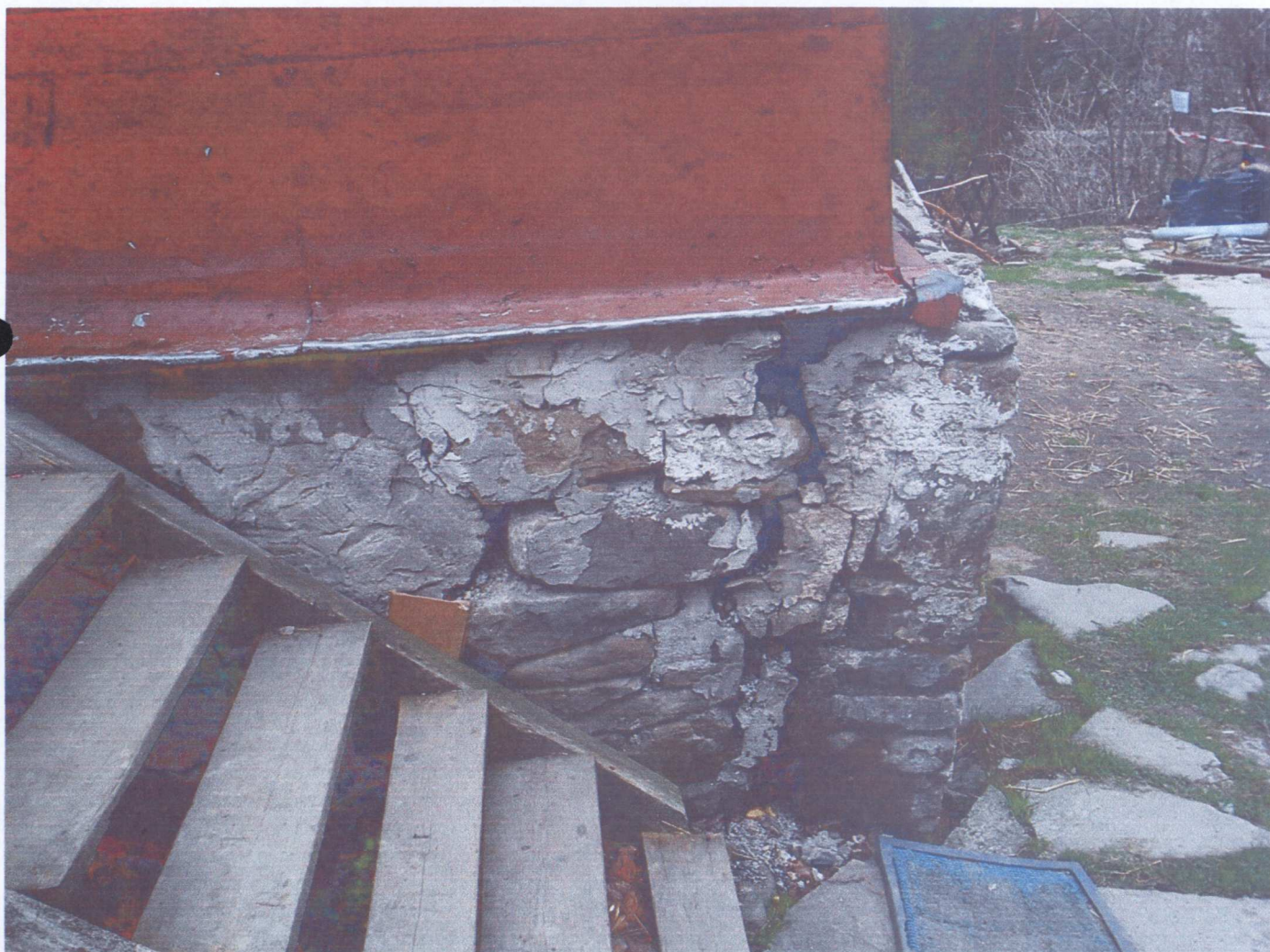
Fot. 2. Uszkodzenie fundamentu budynku nr 2
