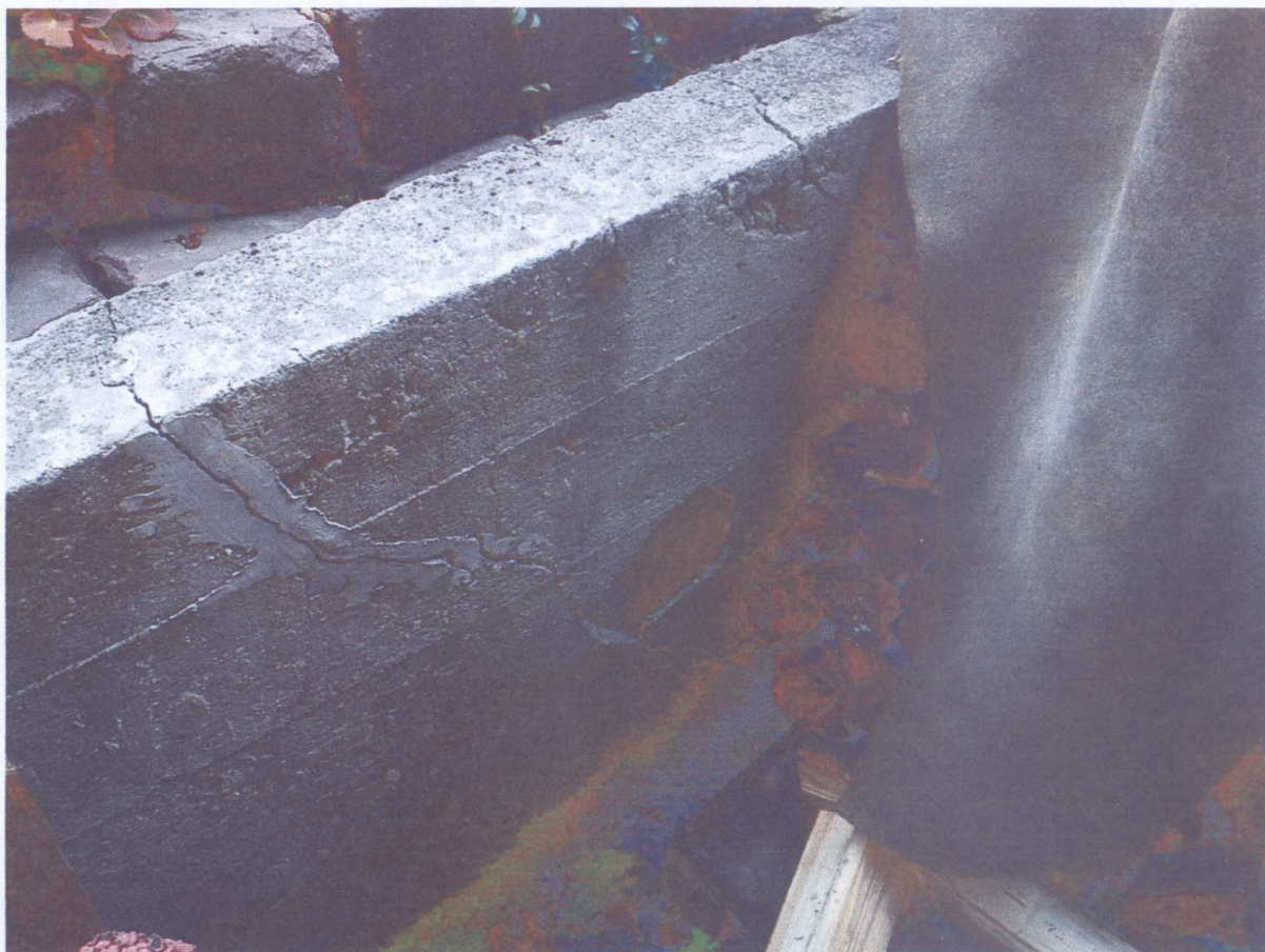
Fot.6. Uszkodzenie muru oporowego od strony stokowej przy budynku nr 8
