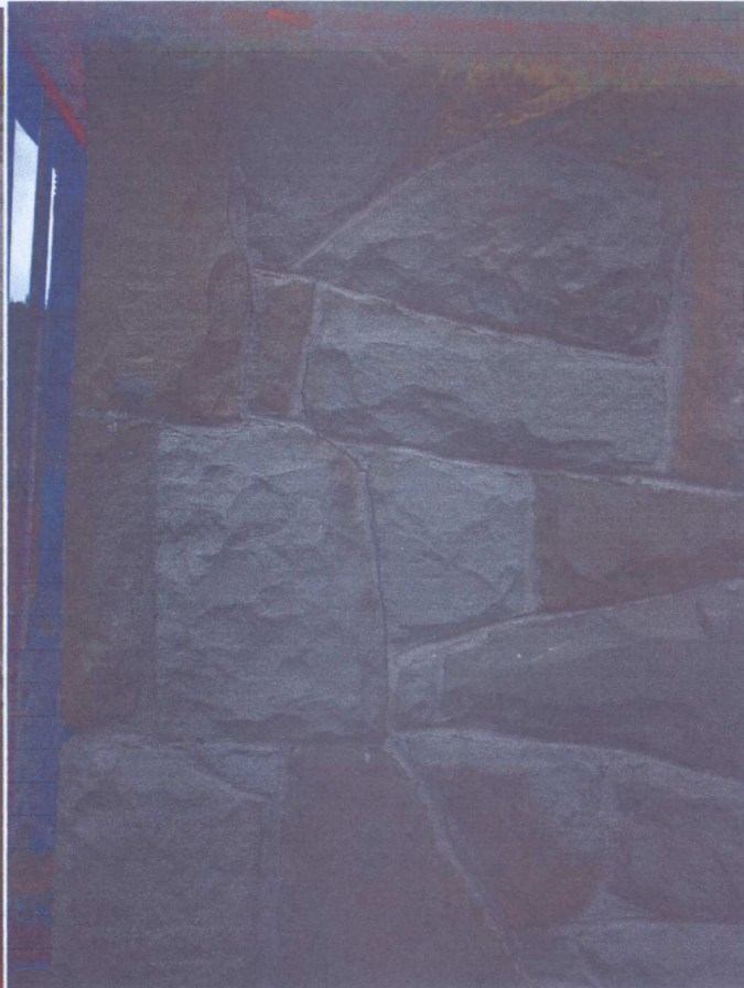
Fot. 10. Pęknięcie fundamentu budynku nr 6
