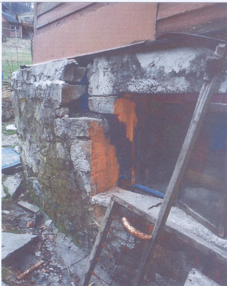
Fot. 1. Uszkodzenie fundamentu budynku nr 2
