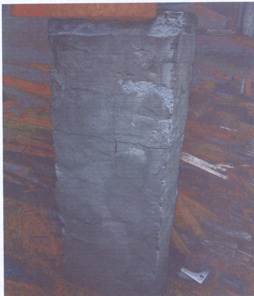
Fot. 4. Pęknięta podpora słupowa ganku, budynku nr 6B
