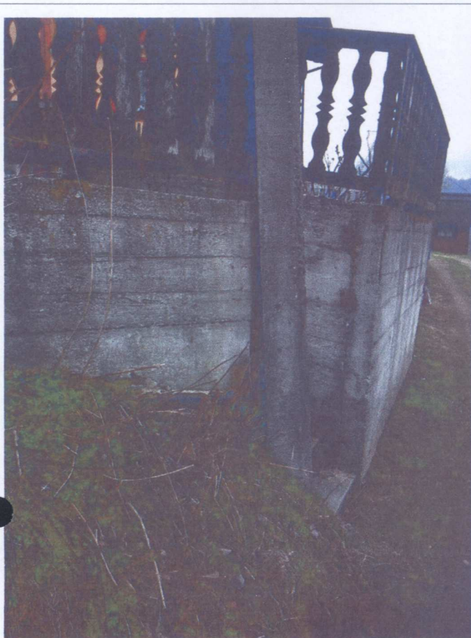
Fot. 7 i 8 Uszkodzony mur oporowy posesji budynku nr 6
