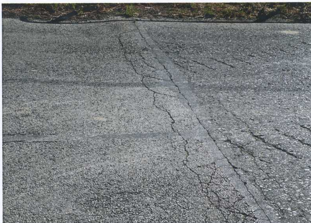
Fot.1 Uszkodzenia nawierzchni , widoczne deformacje w strefie płyt przejściowych.
