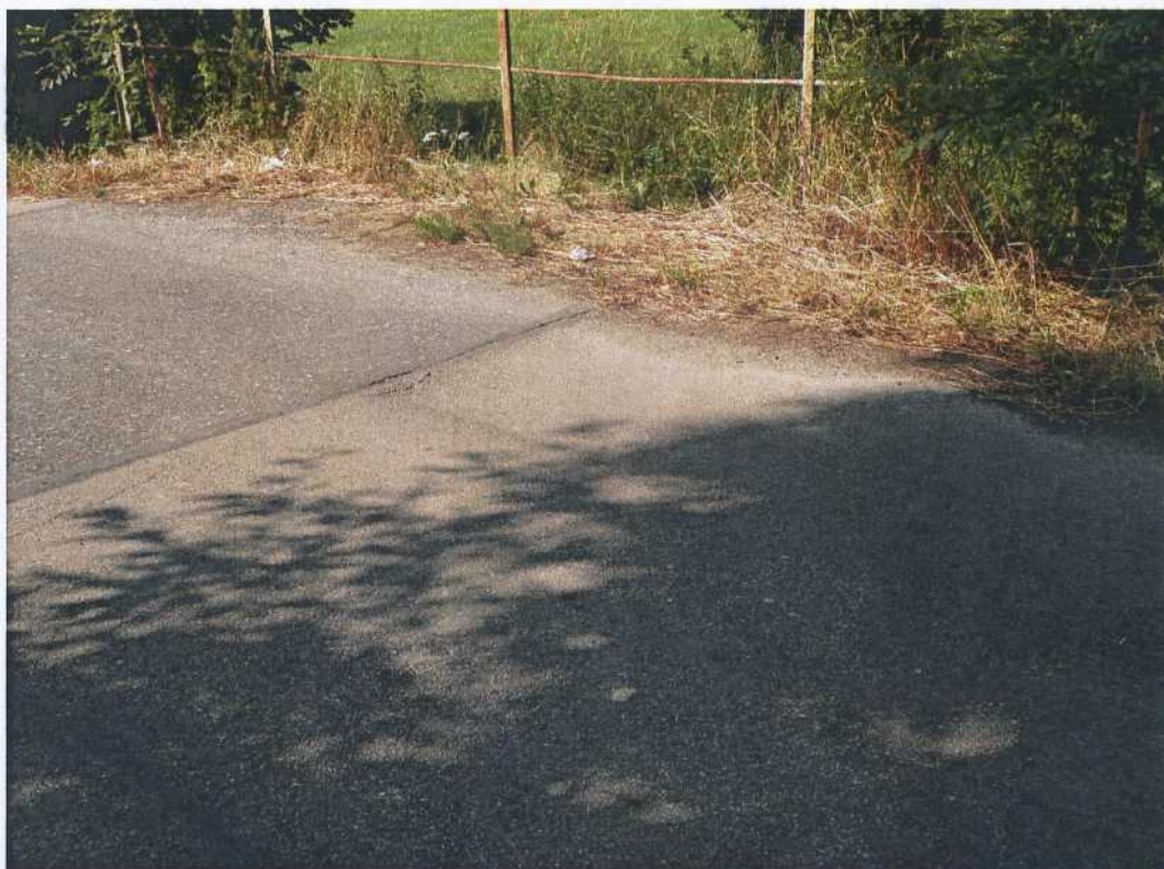
Fot.1 Uszkodzenia nawierzchni , widoczne deformacje w strefie płyt przejściowych.
