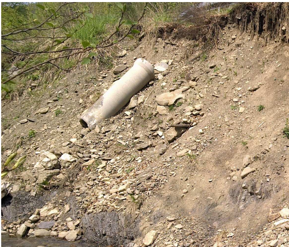
Fot.7. Uszkodzony przepust
