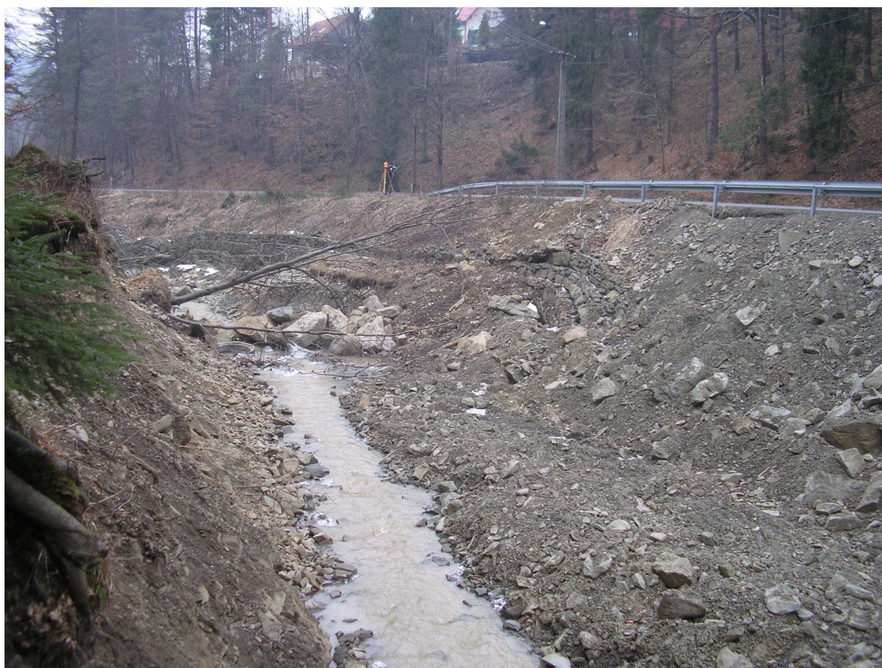
Fot.4. Uszkodzone kosze siatkowo – kamienne
