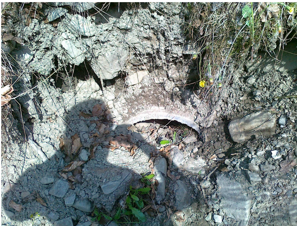
Fot.6. Uszkodzony przepust
