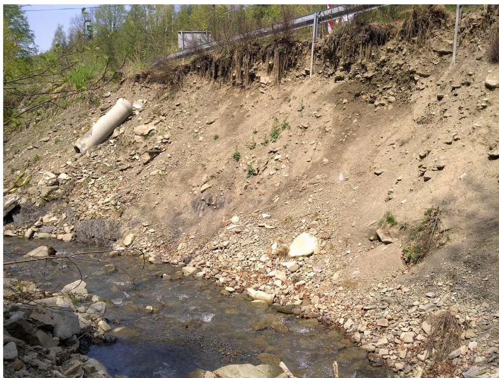
Fot.4. Uszkodzenia nasypu drogowego
