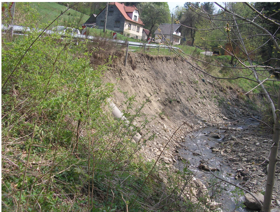
Fot.5. Uszkodzenia nasypu drogowego
