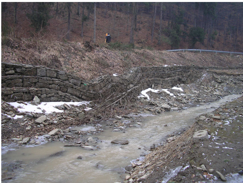
Fot.6. Uszkodzone kosze siatkowo – kamienne\
