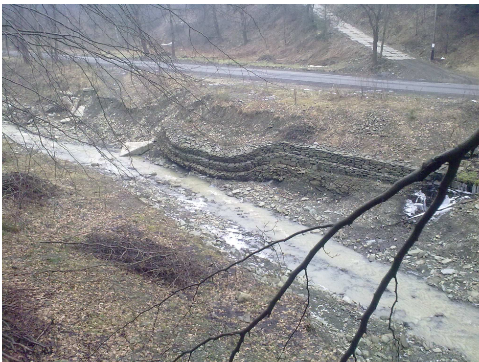
Fot.5. Uszkodzone kosze siatkowo – kamienne
