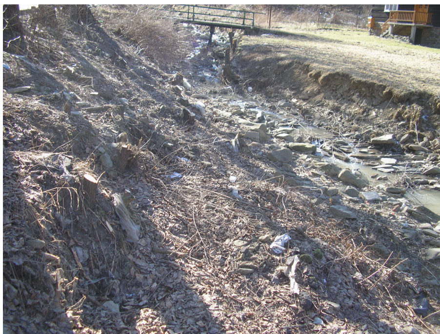
Fot.8.b. Uszkodzone brzegi potoku Mała Puszczka DP S4481 w km 1+050 do 1+086
