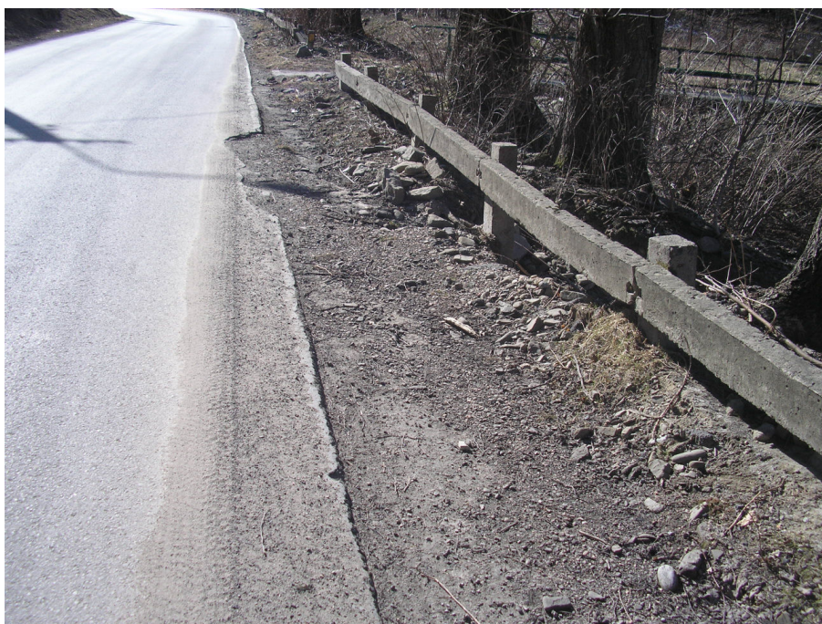
Fot.5.c. Uszkodzona nawierzchnia, pobocze i korpus DP S4481 w km 1+104 do 1+120
