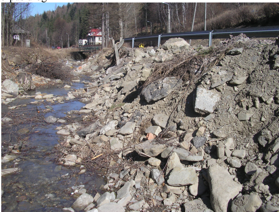
Fot.5.a. Uszkodzony korpus drogi i pobocza DP S4481 w km 1+086 do 1+138
