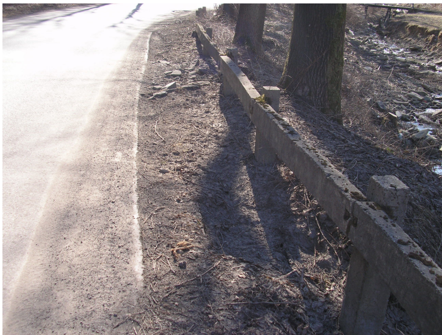
Fot.6.a. Uszkodzone pobocze i korpus DP S4481 w km 1+000 do 1+086
