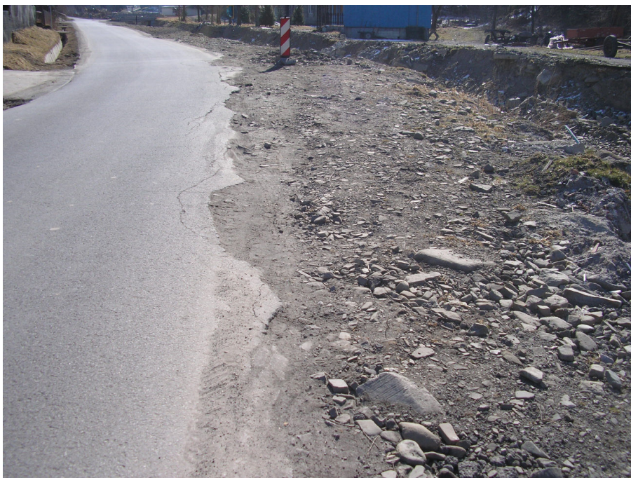
Fot.4.a. Uszkodzona podbudowa, pobocza i korpus DP S4481 w km 1+262 do 1+290
