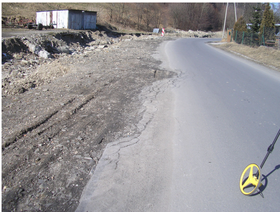
Fot. 1.c Widok ogólny Uszkodzona nawierzchnia, pobocze i korpus drogi w km 1+290 do 1+346
