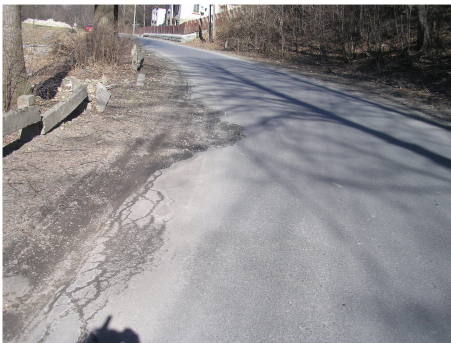
Fot. 1.b Widok ogólny Uszkodzona nawierzchnia i pobocza w km 1+078 do 1+093 drogi powiatowej S4481
