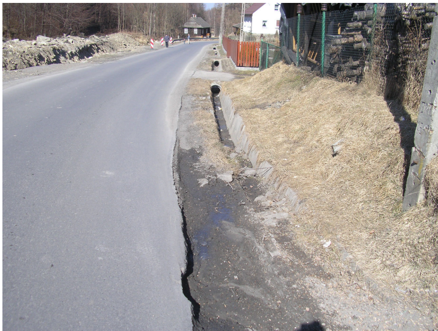
Fot. 2.a. Uszkodzone pobocze, zamulone korytka odpływowe trapezowe obok posesji nr. 35 w km 1+200 do 1+220
