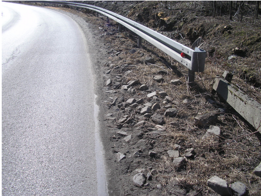
Fot.2.b. Uszkodzone pobocze DP S4481 w km 1+086 do 1+138
