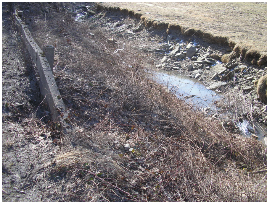
Fot.8.c. Uszkodzone brzegi potoku Mała Puszcza DP S4481 w km 1+000 do 1+086
