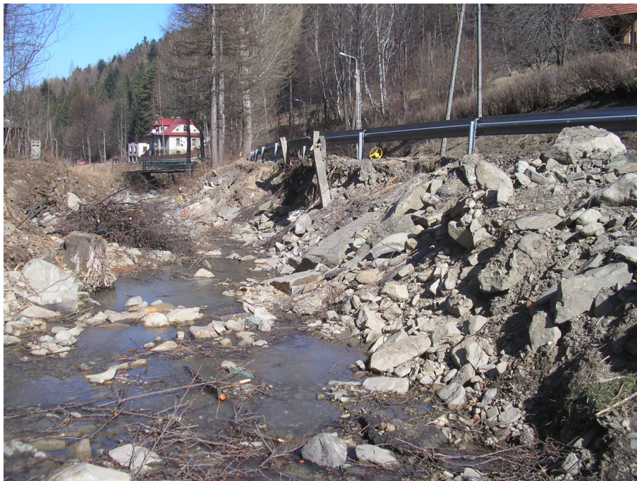
Fot.7.b. Uszkodzony korpus drogi S4481 w km 1+086 do 1+138
