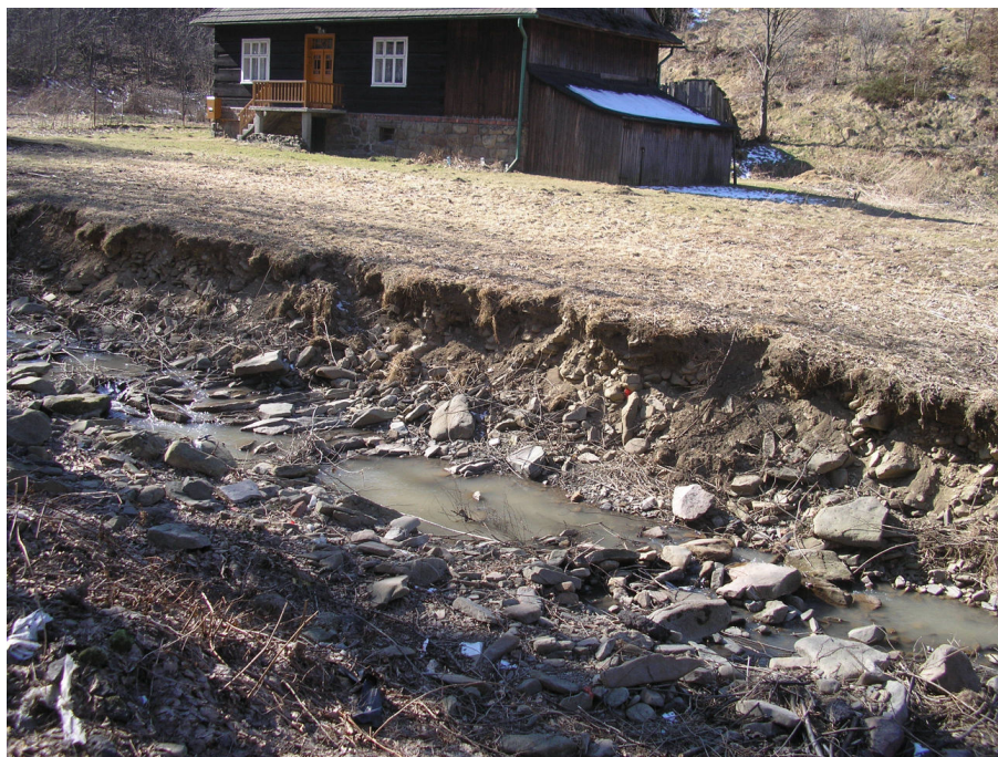
Fot.8.a. Uszkodzone brzegi DP S4481 w km 1+065
