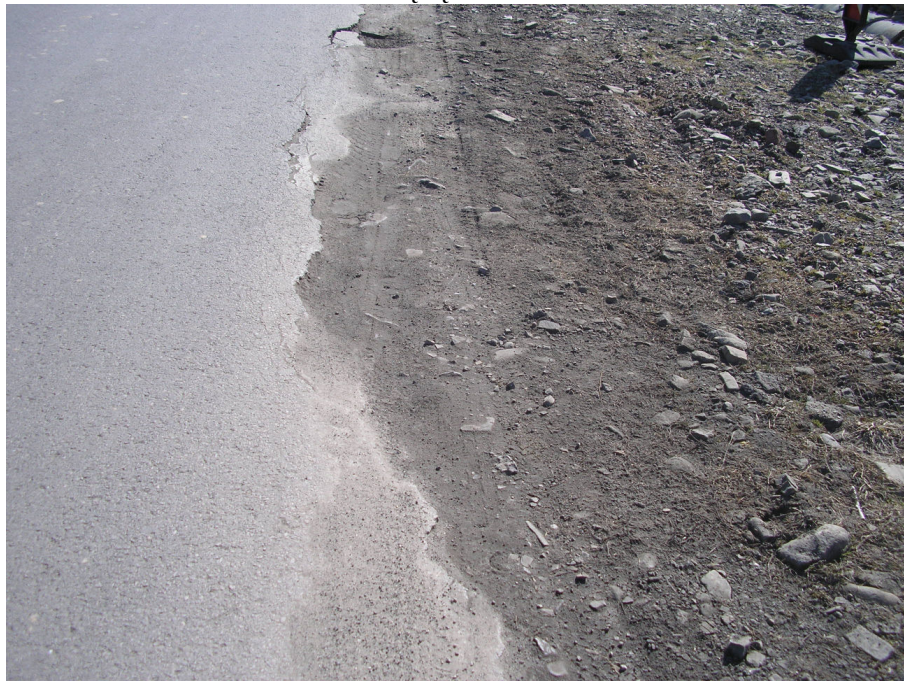
Fot.3.a. Uszkodzona nawierzchnia, pobocze i podbudowa w km 1+290 do 1+317
