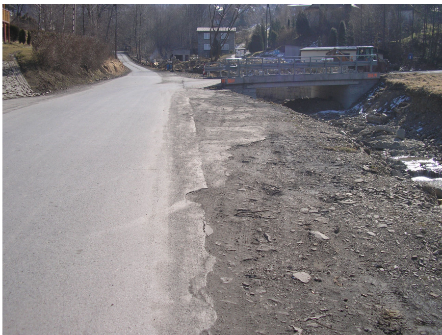
Fot. 1.a Widok ogólny drogi i potoku Uszkodzona wierzchnia, pobocze i korpus drogi w km 1+364 do 1+390
