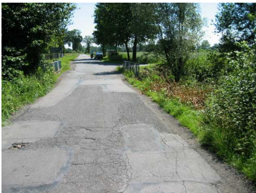
Fot. 3. Uszkodzenia jezdni od strony Kaniowa.
