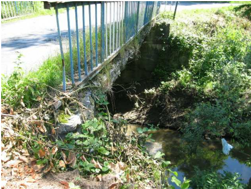
Fot. 2. Uszkodzona płyta pomostu zespolonego- po obydwóch stronach mostu.
