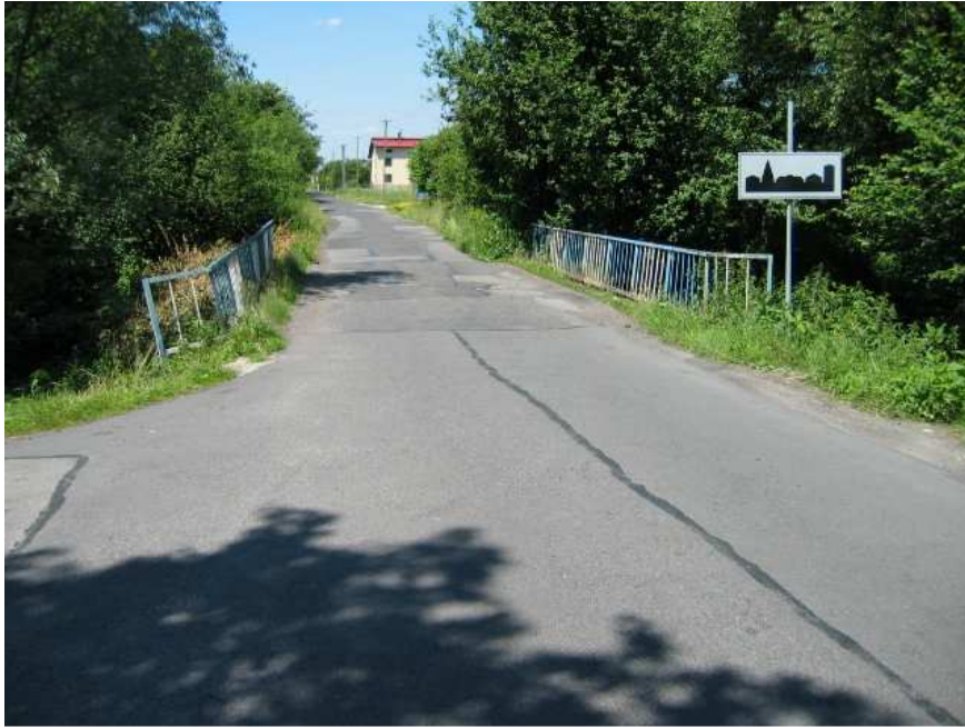
Fot. 1. Uszkodzone balustrady z obydwóch stron mostu.
