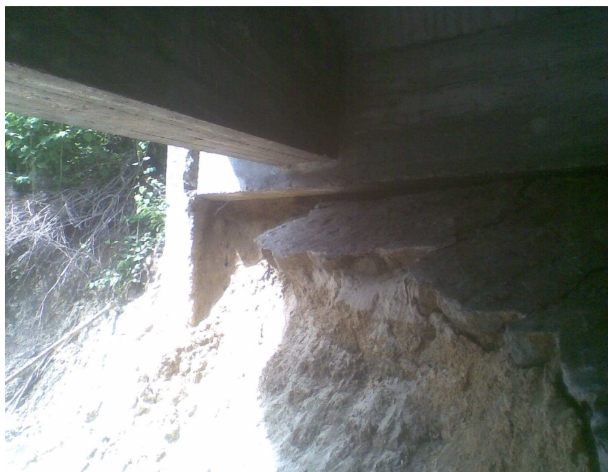
Fot. 10. Widok na uszkodzony przyczółek i zabezpieczenie skarpy od strony Czechowic-Dziedzic
