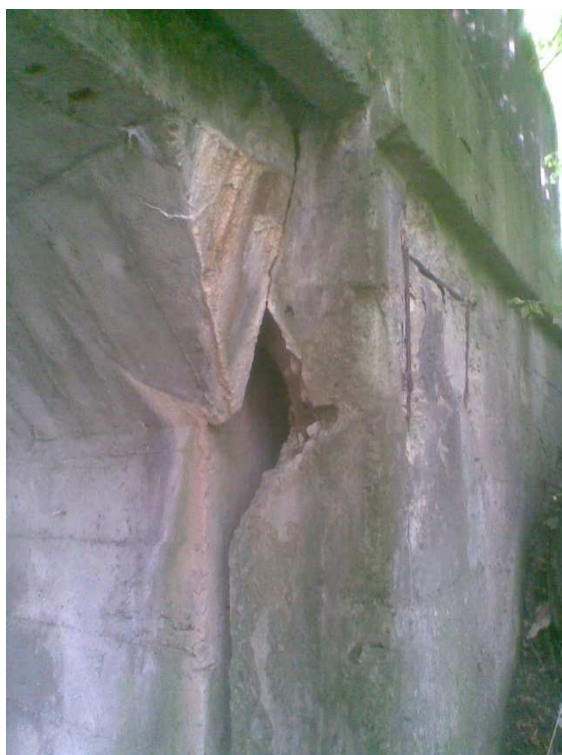
Fot. 9. Widok na uszkodzony przyczółek i wspornik pomostu od strony Czechowic-Dziedzic
