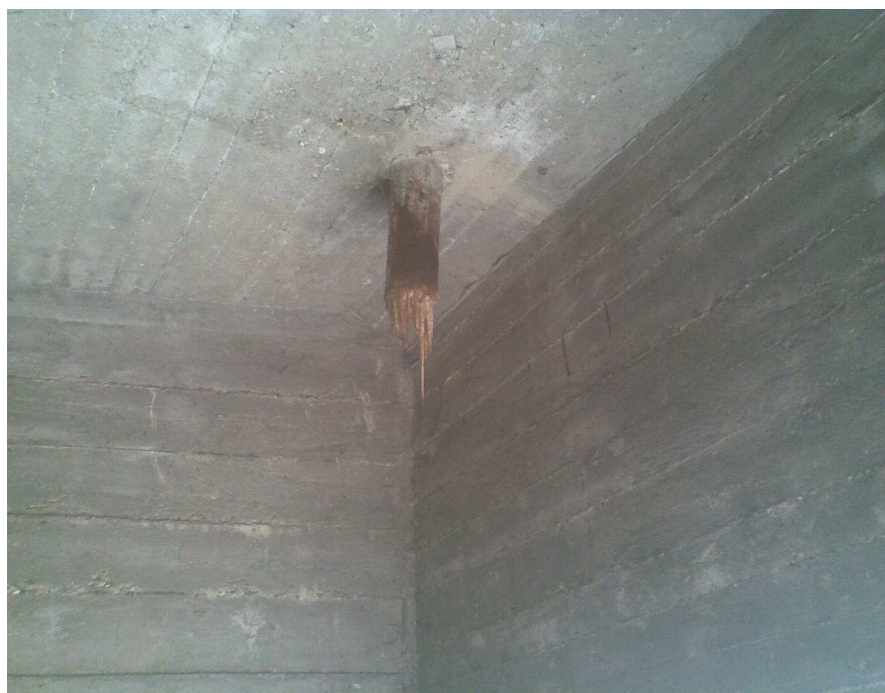
Fot. 5. Widok na zatkaną rurę odwadniającą pomost mostu
