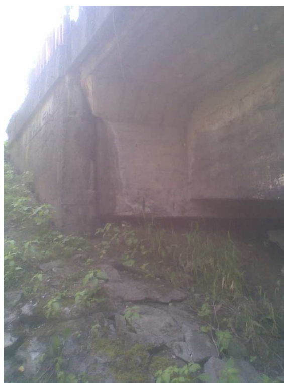
Fot. 8. Zacieki i uszkodzenia przyczółka i wspornika od strony Bestwiny
