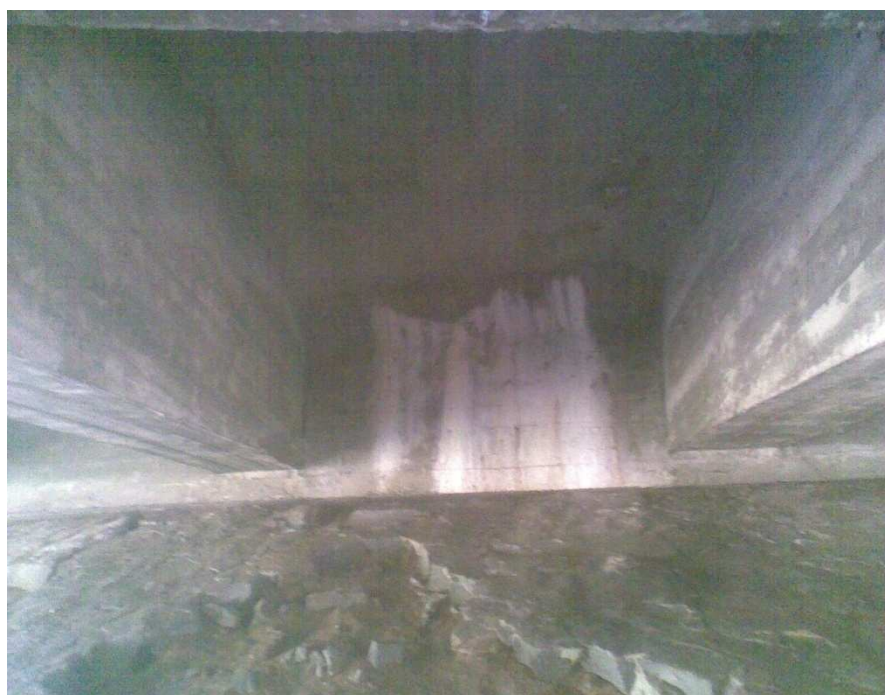
Fot. 6. Zacieki na poprzecznicy skrajnej wspornika od strony Bestwiny
