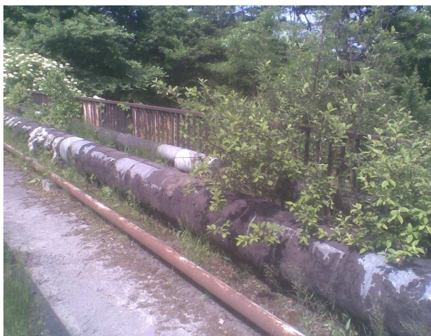
Fot. 12. Widok na uszkodzenia i zacieki wspornika chodnika i dźwigara pomostu
