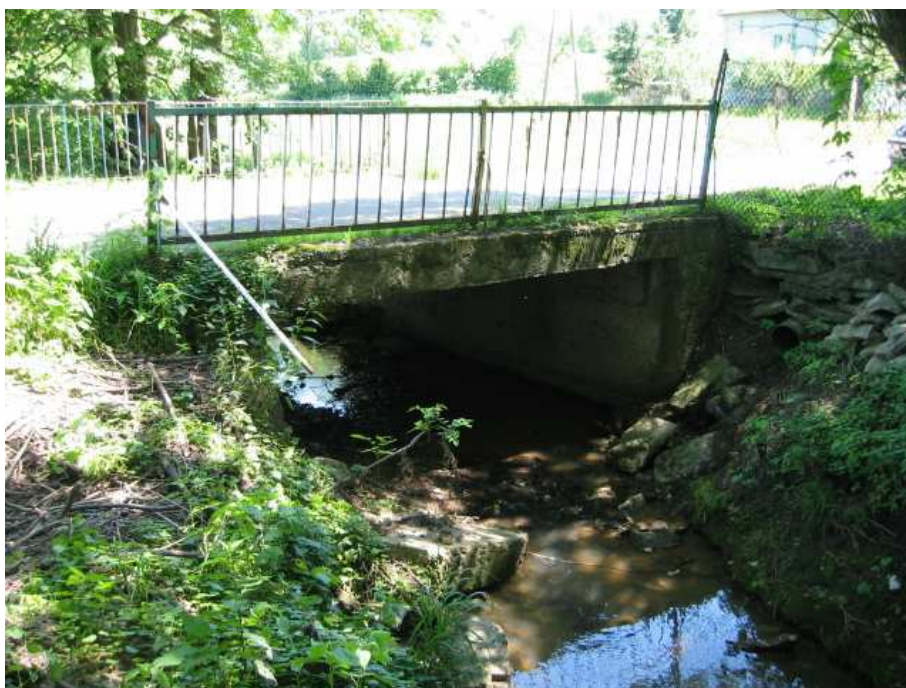
Fot. 3. Uszkodzona płyta, zniszczona ściana oporowa i balustrada.
