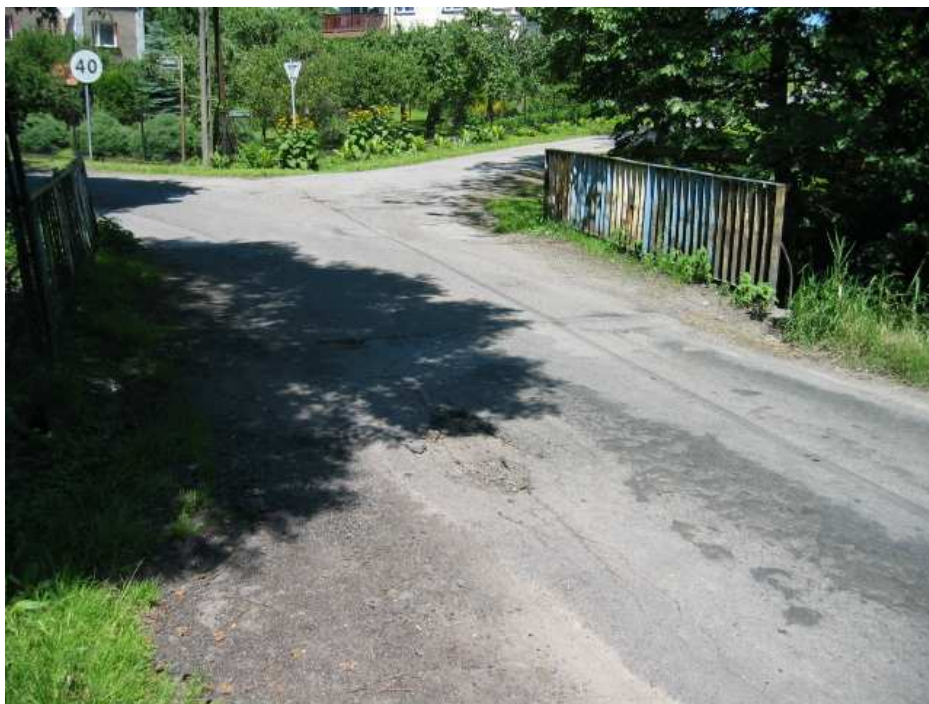
Fot. 1. Deformacja nawierzchni i ubytki w strefie dojazdów.
