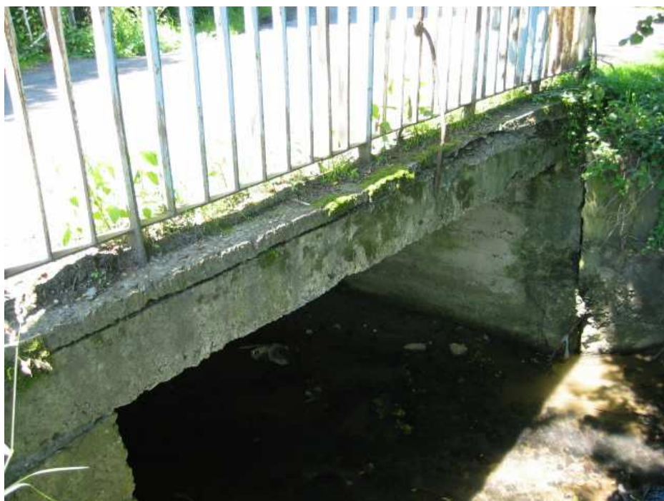
Fot. 2. Rozwarstwiona płyta pomostu, uszkodzenia korpusu i ściany oporowej.
