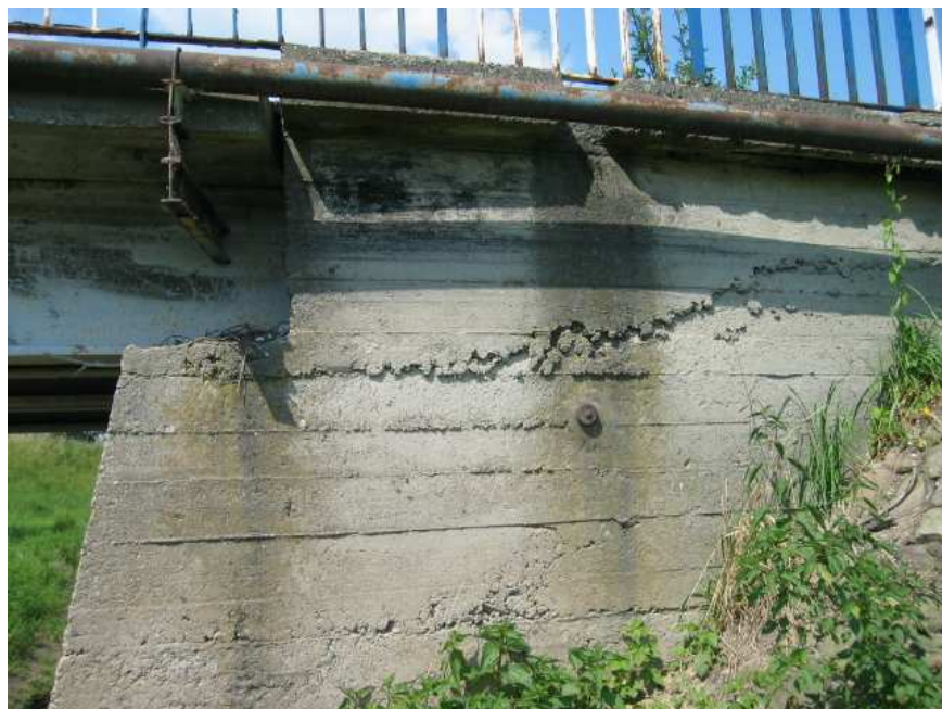
Fot. 2. Lokalne uszkodzenie gzymsu od strony Jawiszowic.
