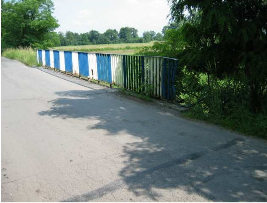
Fot. 3. Deformacje lokalne i uszkodzenie zabezpieczenia antykorozyjnego balustrad.
