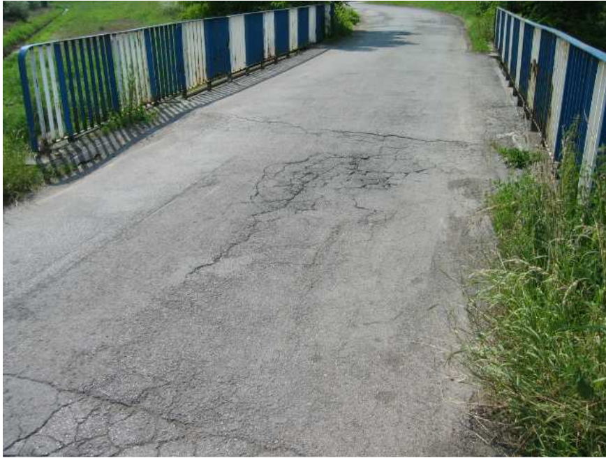
Fot. 1. Uszkodzenia nawierzchni i widoczne podmycie stref płyt przejściowych.
