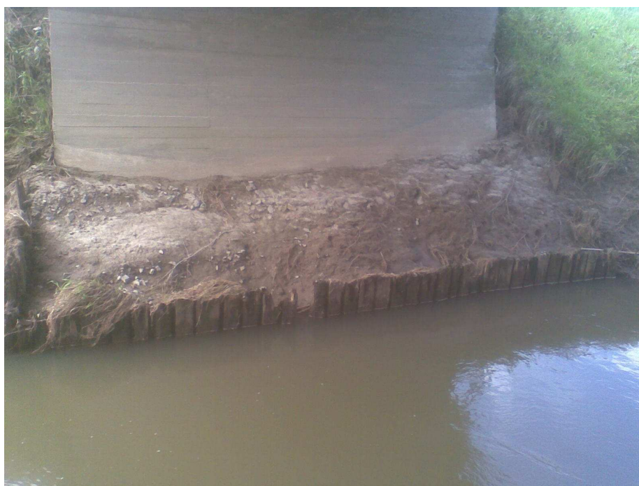
Fot. 2. Widok na zabezpieczenie podpory południowej mostu.
