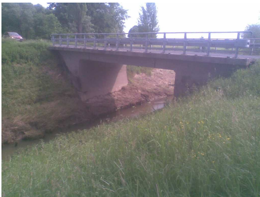
Fot. 1. Widok na uszkodzone zabezpieczenie podpory północnej mostu.
