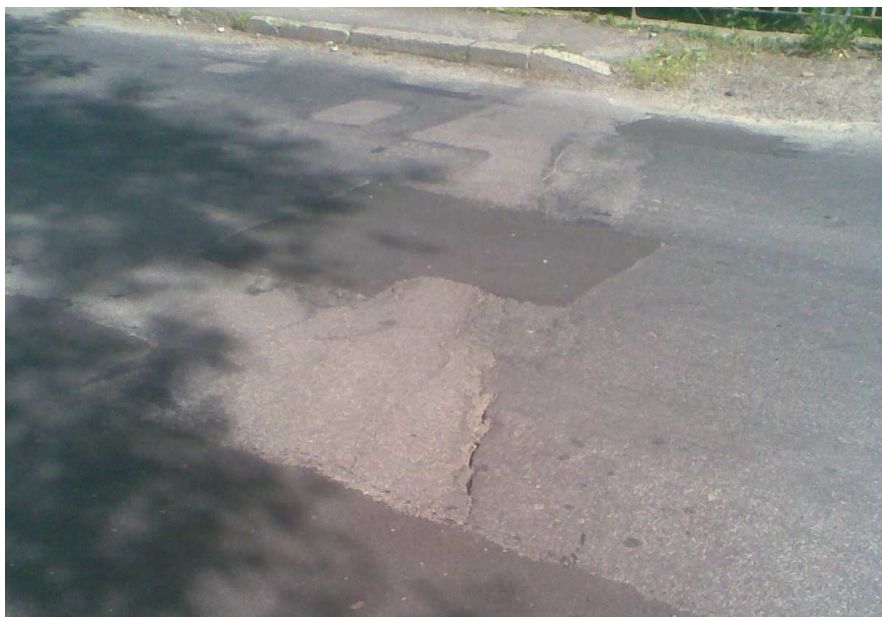
Fot. 15. Ubytki nawierzchni jezdni nad strefą dylatacji, uszkodzona dylatacja.
