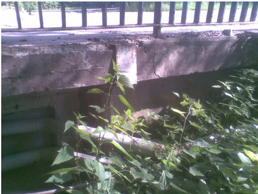
Fot. 10. Lokalne uszkodzenia gzymsu do strony południowej.
