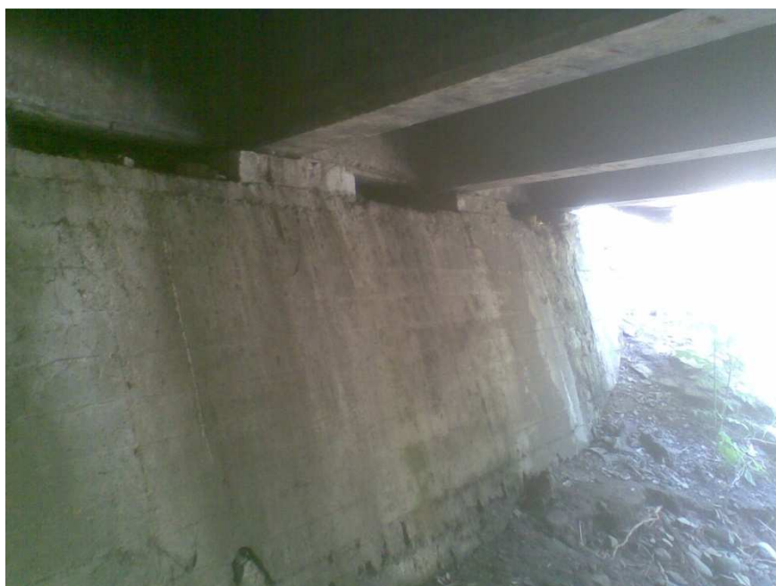
Fot. 4. Uszkodzenie korpusu przyczółka od strony Jasienicy.
