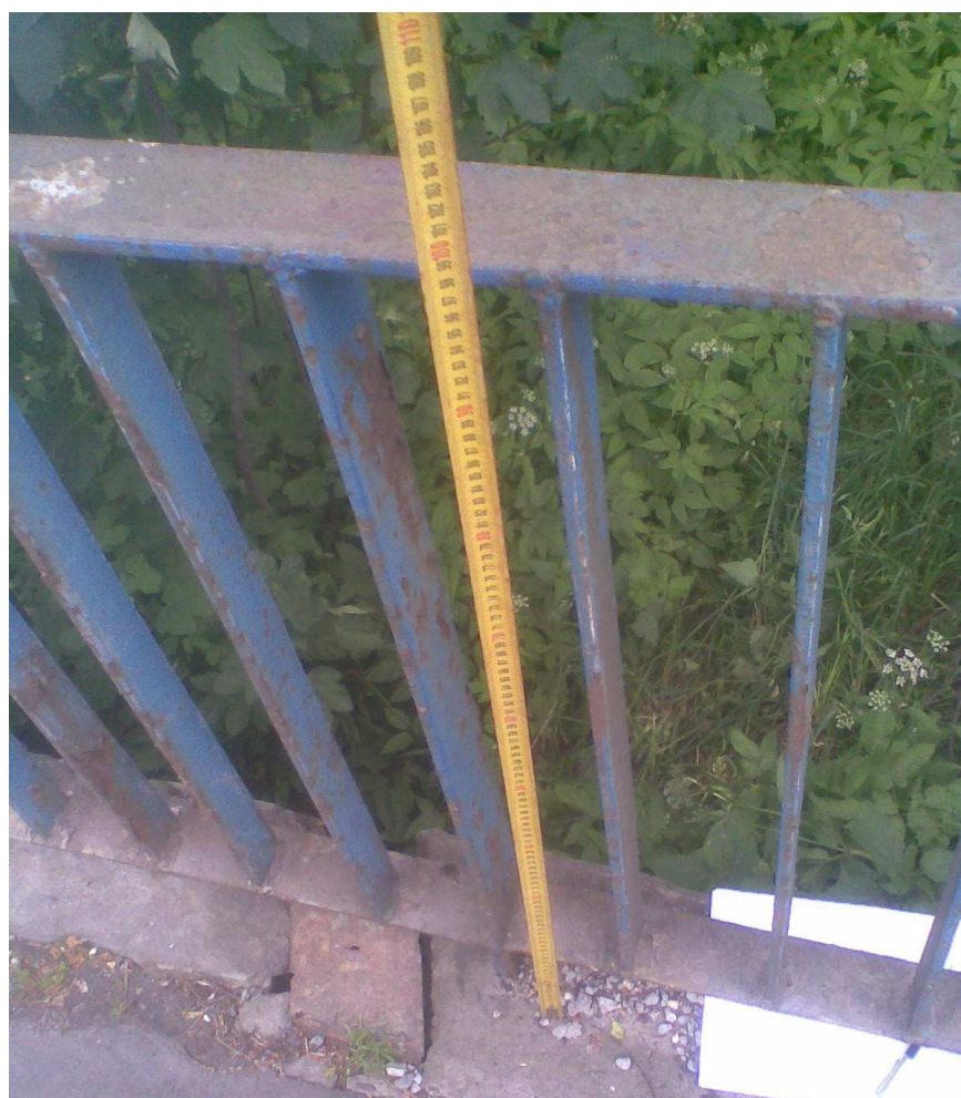
Fot. 16. Nieodpowiednia wysokość balustrady po obu stronach obiektu na całej długości.
