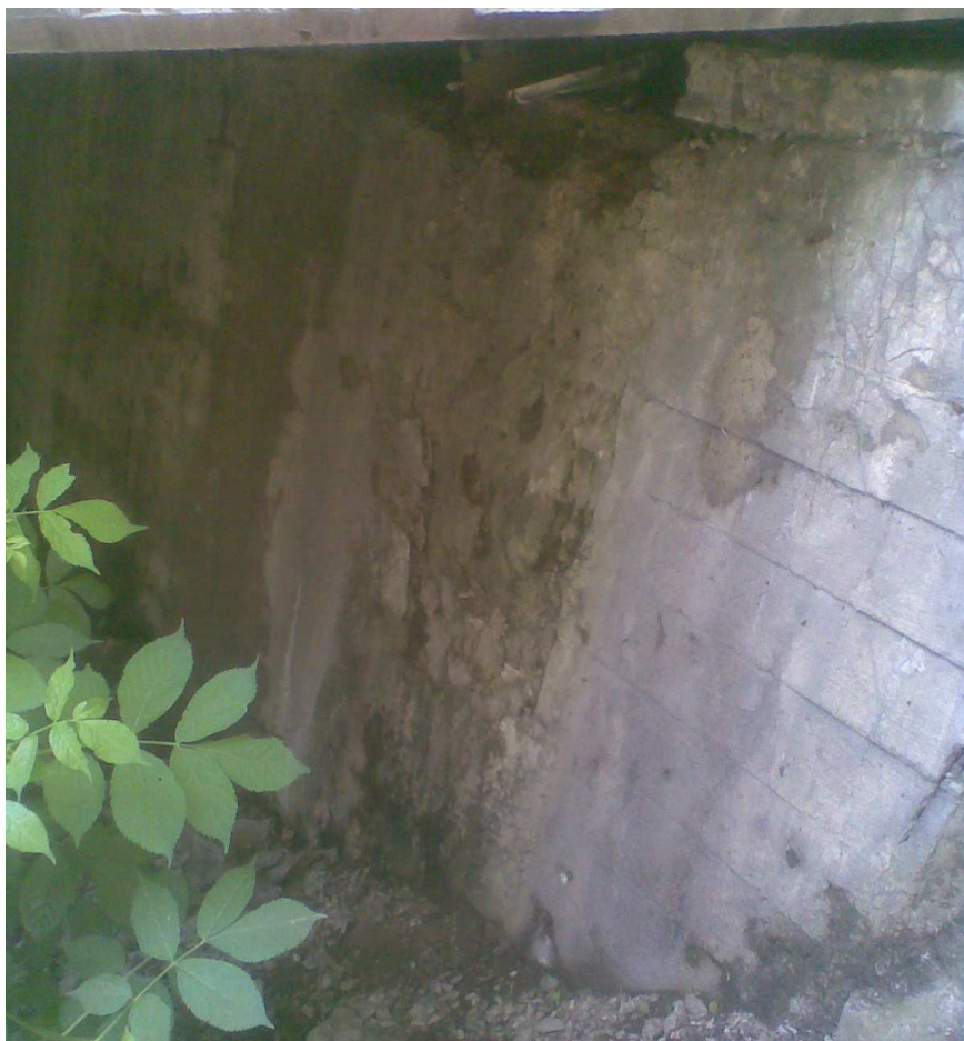
Fot. 3. Uszkodzenie ściany korpusu przyczółka od strony Jasienicy.
