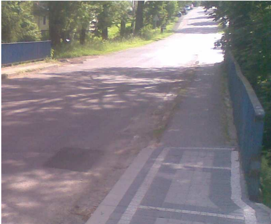
Fot. 11. Deformacja balustrady. Podmyta jezdnia przy chodniku w strefie dylatacji.
