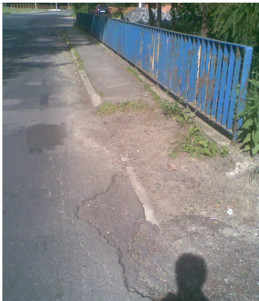
Fot. 14. Znaczne ubytki nawierzchni asfaltowej chodnika w strefie dylatacji.
