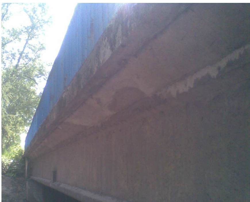
Fot. 8. Uszkodzona dolna powierzchnia wspornika od strony północnej.
