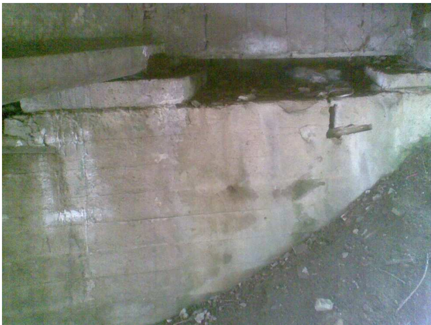
Fot. 6. Lokalne uszkodzenia korpusu przyczółka od strony Jaworza.
