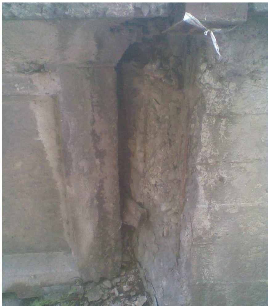
Fot. 2. Degradacja przyczółka od strony Jasienicy.
