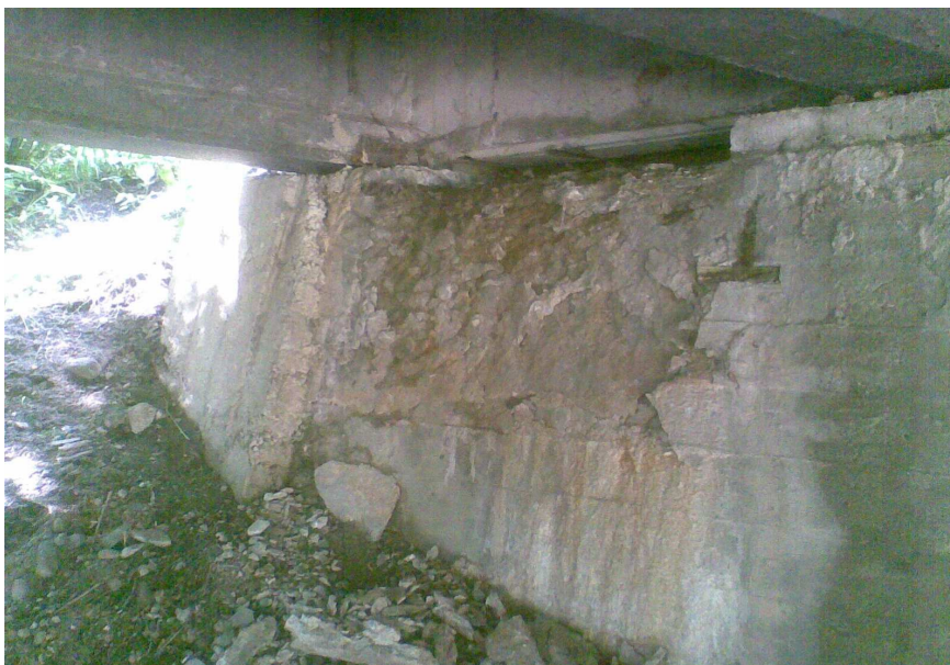
Fot. 1. Ubytki korpusu przyczółka od strony Jasienicy.
