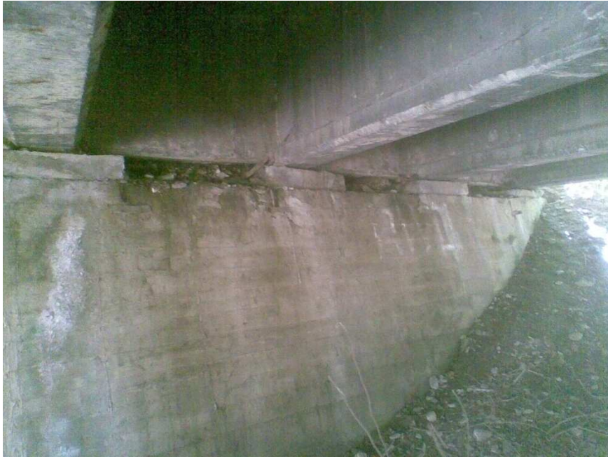
Fot. 5. Zanieczyszczenia stref ciosów podłożyskowych od strony Jaworza.
