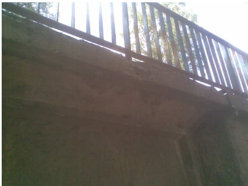
Fot. 7. Uszkodzony gzyms na całej długości pomostu od strony północnej.
