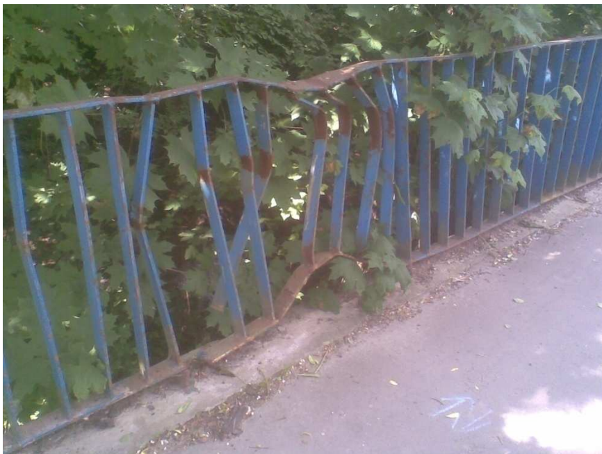
Fot. 12. Uszkodzenie balustrady od strony południowej.
