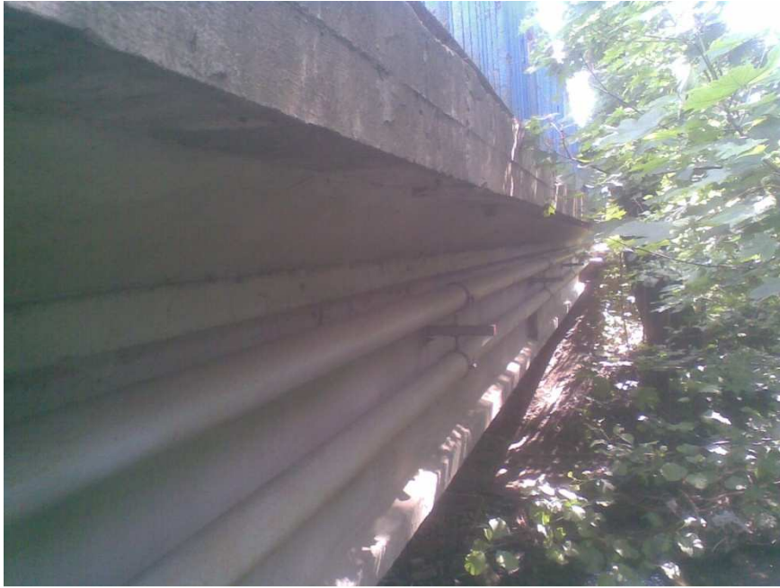
Fot. 9. Ubytki powierzchni czoła gzymsu od strony południowej.
