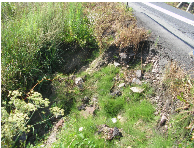
Fot. 5 Ubytki w nasypach w rejonie przepustów
