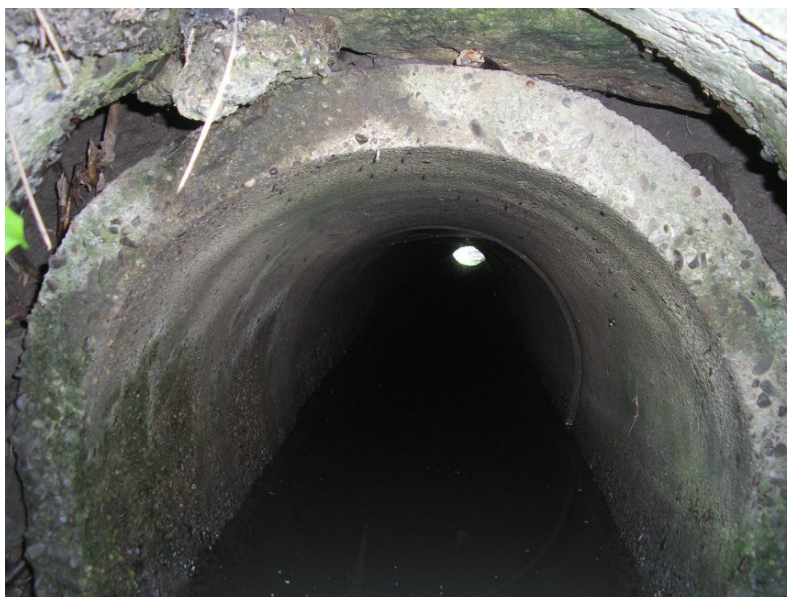
Fot. 5 Widok wewnątrz przepustu Ø50cm
