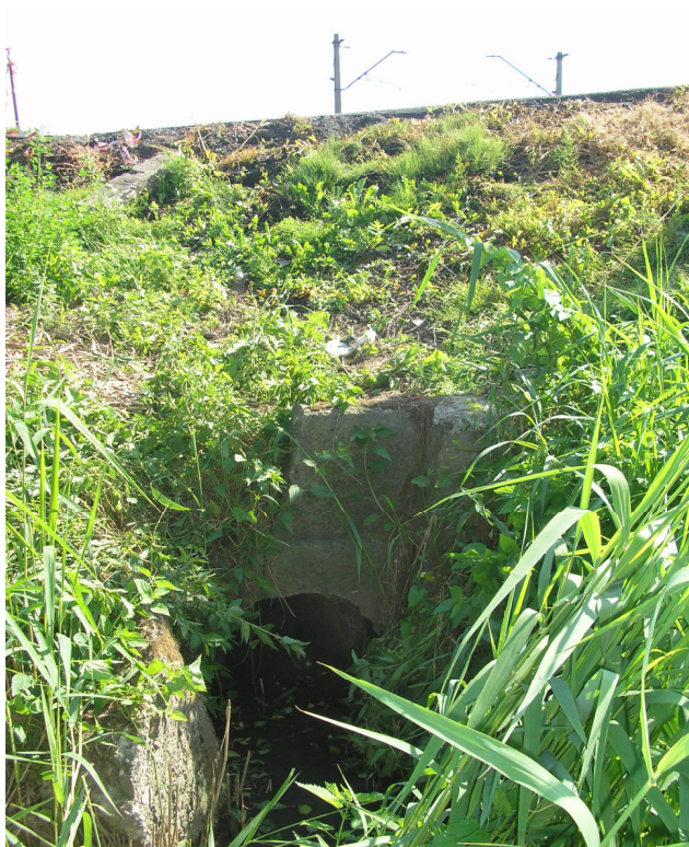
Fot. 2 Widok od strony wlotu przepustu Ø50cm
