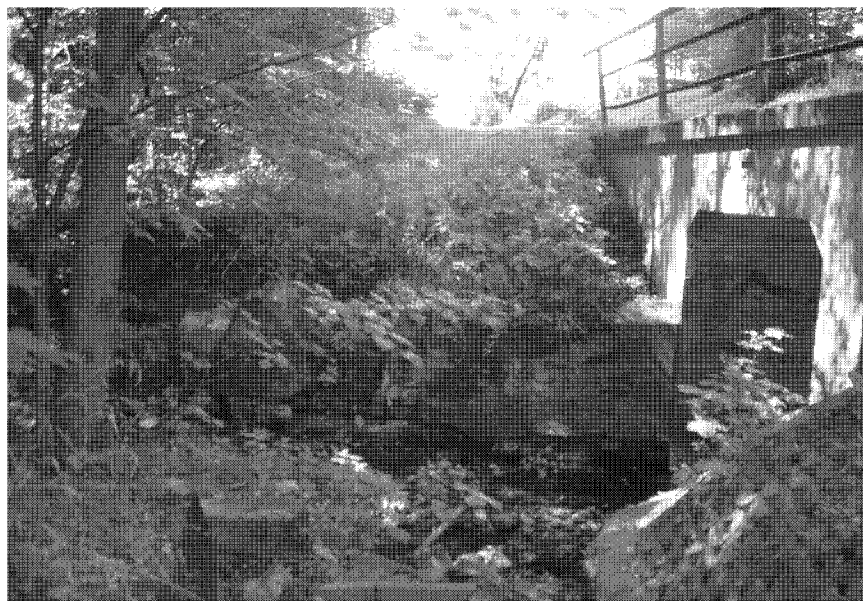
Fot. 8 Uszkodzone umocnienie lewego stożka.
