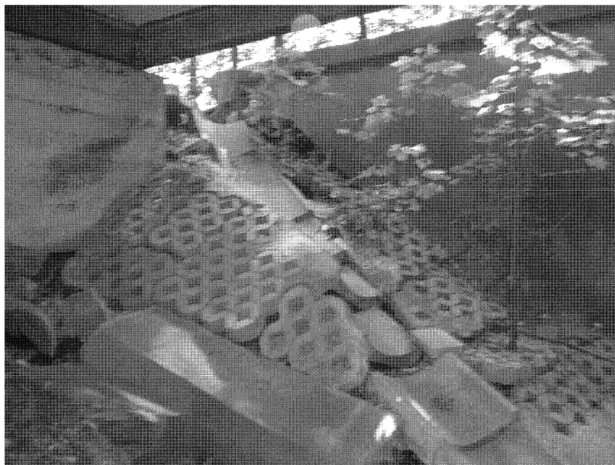
Fot. 10. Uszkodzone umocnienie prawego stożka.
