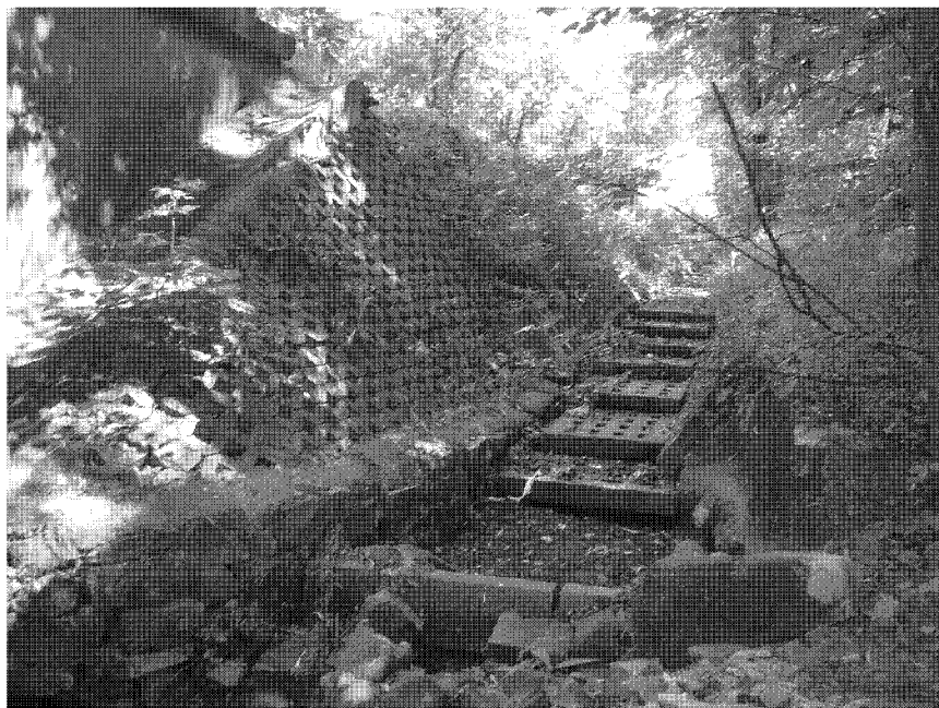
Fot. 13 Uszkodzone umocnienie rowu drogowego
