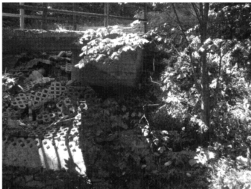
Fot. 9. Uszkodzone umocnienie lewego stożka.
