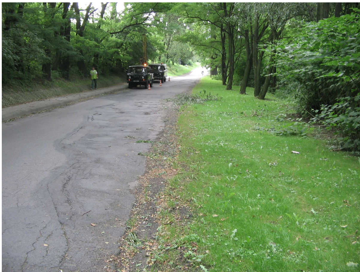
Fot. nr 2. Na zdjęciu widoczne jest półkoliste załamanie nawierzchni jezdni, podcięcie stoku po stronie wschodniej oraz nachylenie pni drzew w kierunku skarpy, po stronie przeciwnej.
