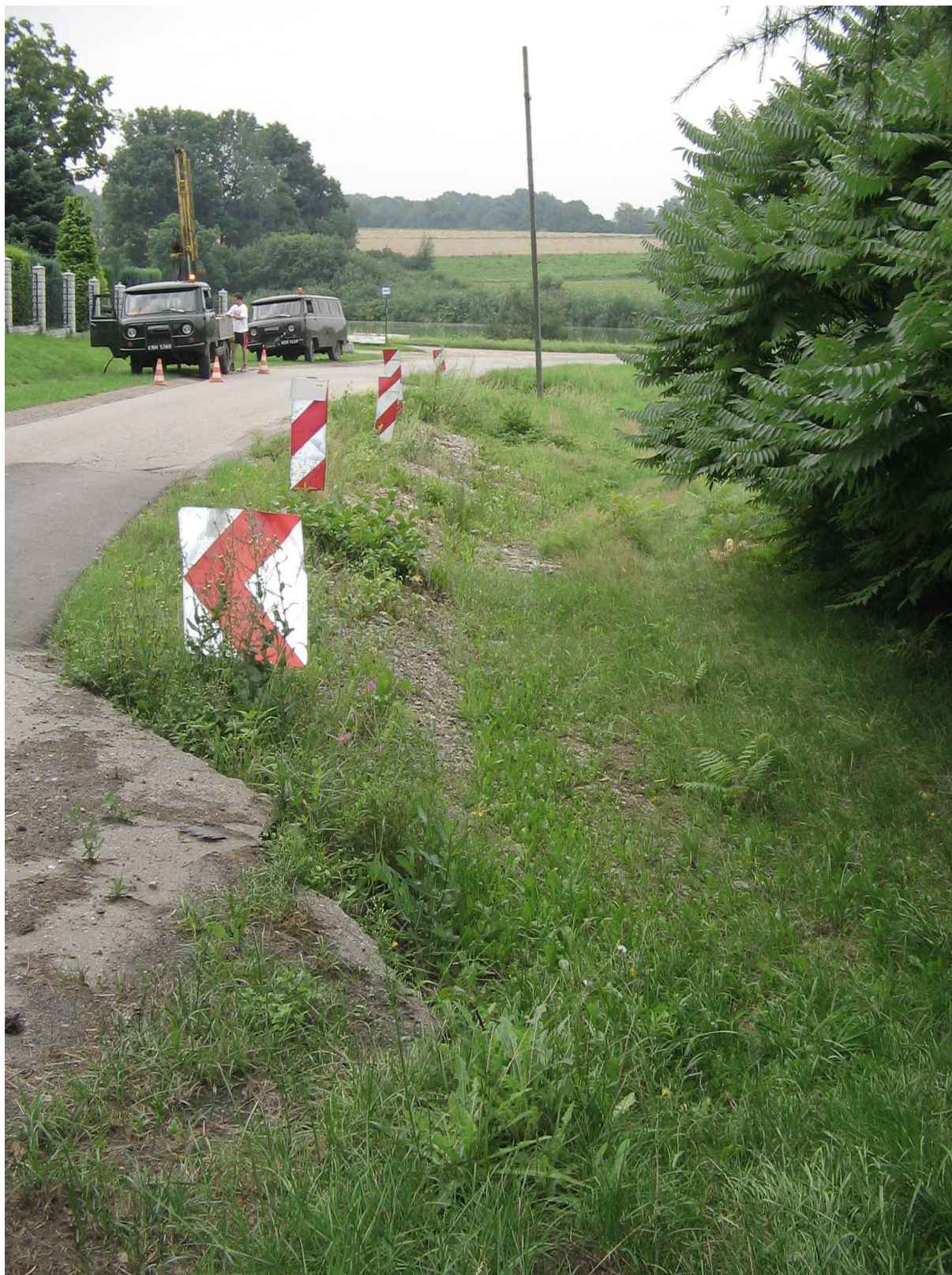
Fot. nr 3. Południowy odcinek – rejon lokalizacji siatki wyrobisk badawczych. Zdjęcie wykonano od strony północnej. Widoczna zawężona, w wyniku oberwania nawierzchni, jezdnia drogi powiatowej oraz zaburzenia powierzchni po stronie prawej, w miejscu osuwania się gruntów.
