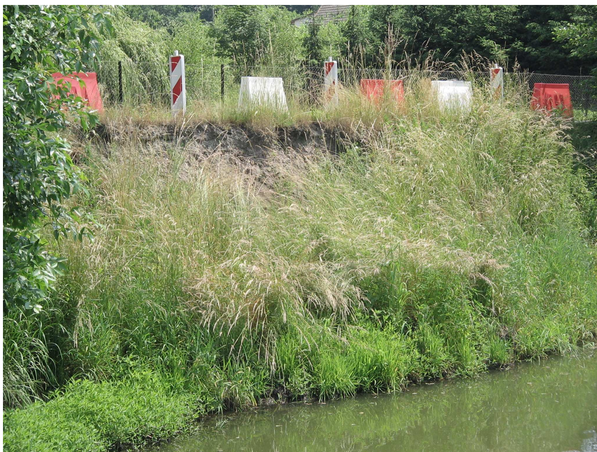
Fot. nr 2. Północny odcinek. Na zdjęciu widoczny obryw, powstały w efekcie podmywania skarpy, po której biegnie droga powiatowa, przez wody stawu rybnego. Powyżej skarpy wykonano otwory badawcze nr 1 i 2.
