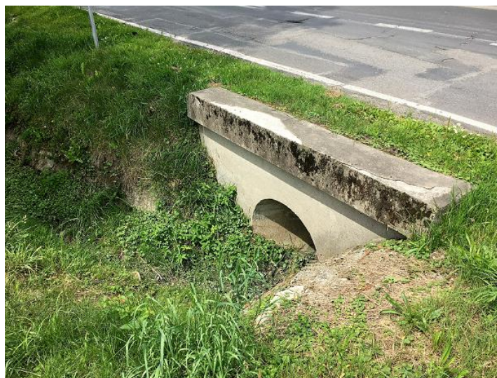
Widok na wlot przepustu drogowego fi 800 mm bezpośrednio za punktem ZRZUTU nr 1
